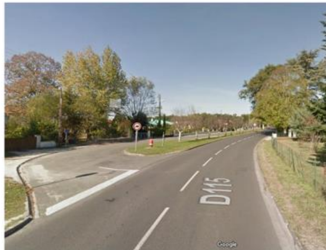
Contre Allée Nord route de Lignan
