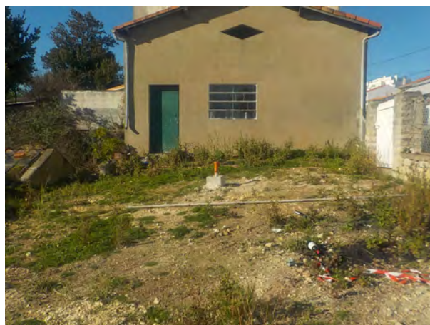
10. Garage en partie Nord-est du site (février 2021)
