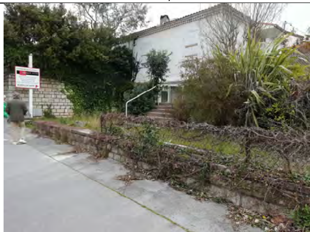
7. Vue du site depuis la rue Font de Chêrves (mars 2021)
