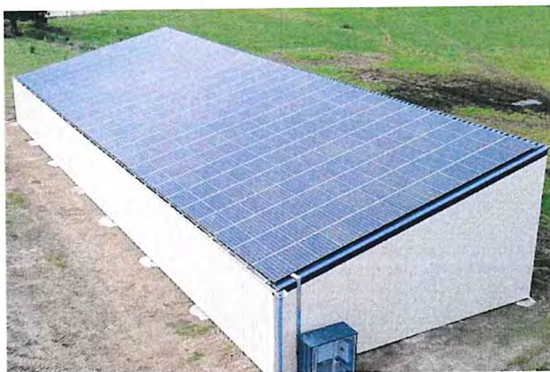
Figure 6 Toiture photovoltaïque sur hangar agricole
