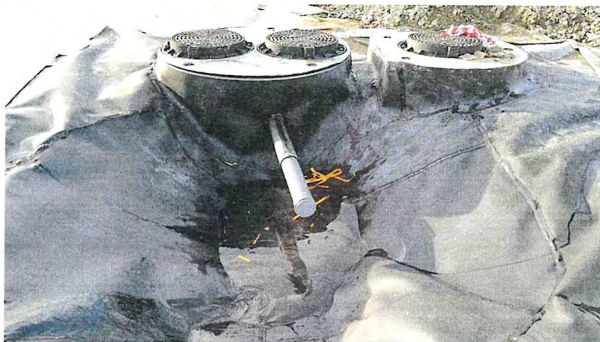
Exemple d'habillage complet d'un ouvrage béton avec la géomembrane
