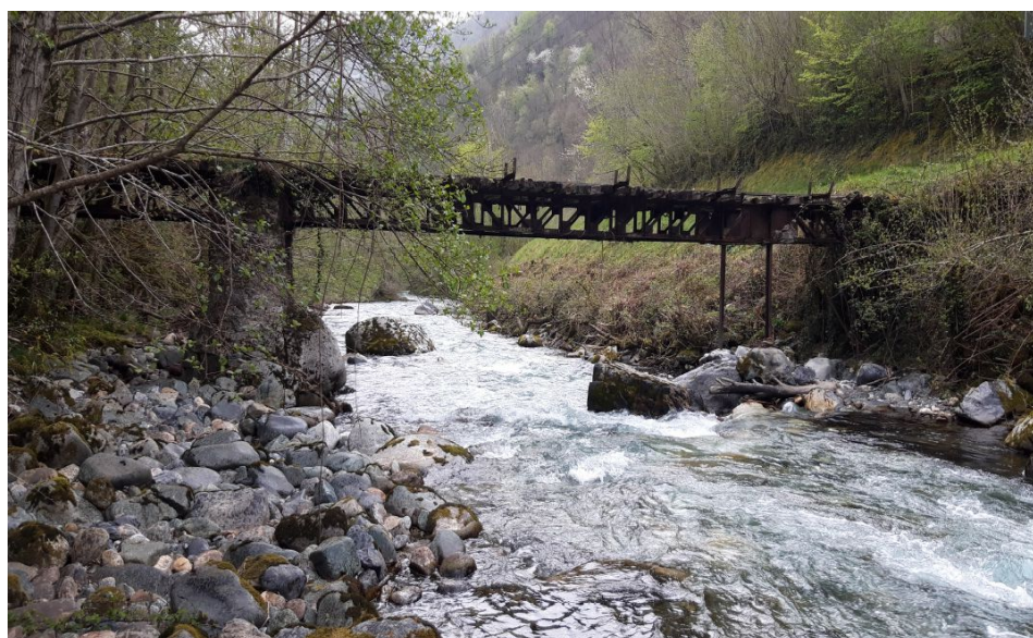
Figure 3. Vue de la passerelle amont
