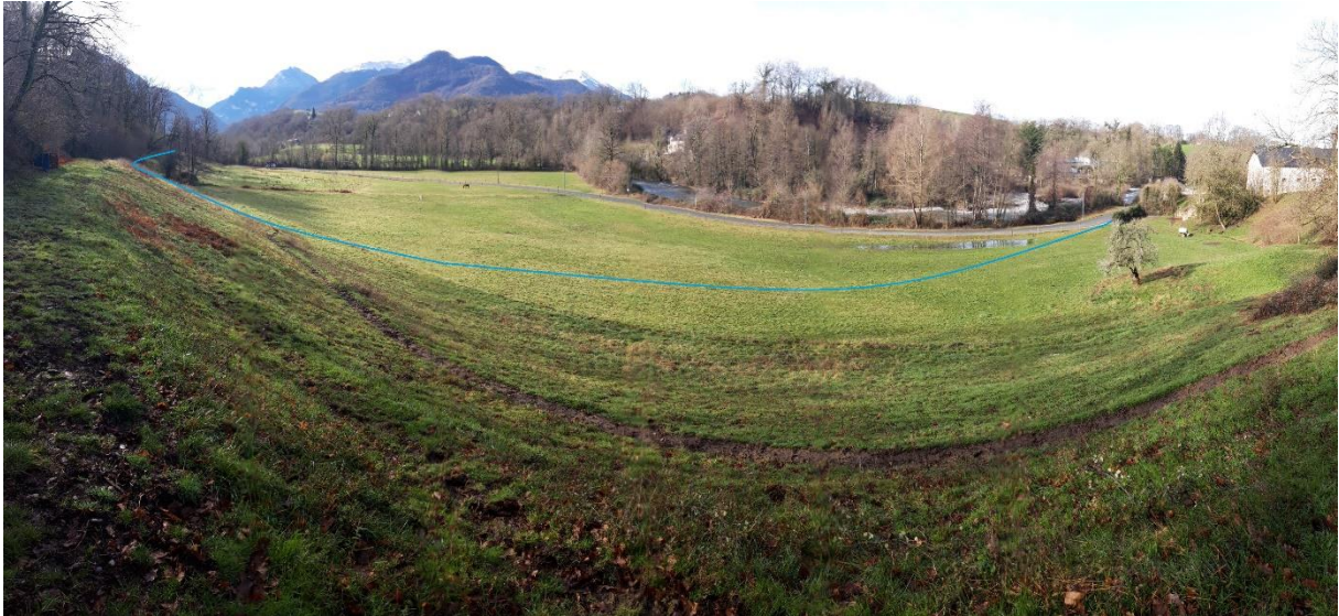
Tronçon n°47 aval
