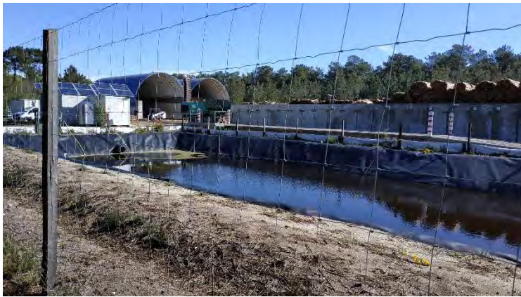
Bassin de rétention bâché au nord du site d'étude dans lequel une « grenouille verte » a été observée (S. Albinet – Artifex)
