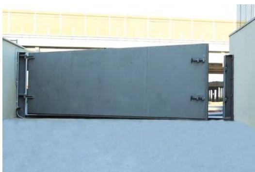
Figure 97 : Exemples de batardeaux amovibles ou de portail contre les inondations
