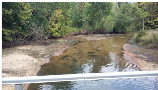
Photographie 2 : Vue de l'aval immédiat de l'OH P pour réalisation d'un nouvel ouvrage (source : BURGEAP, 28/08/2019)
