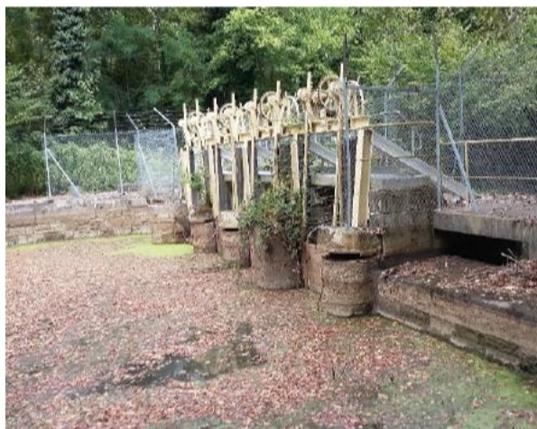
Photographie 1 : vue amont de l'OH V (source : BURGEAP, août 2019)
