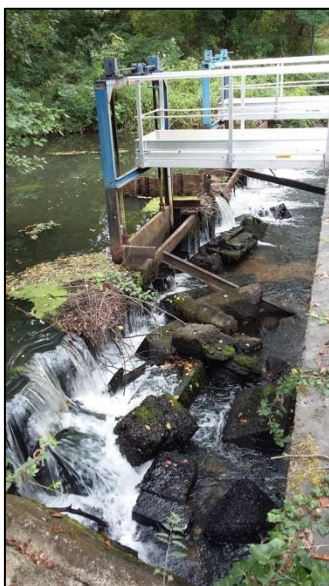
Photographie 1 : Vue vers l'amont depuis le pont franchissant la Jalle (deux vannages et seuils associés) (source : BURGEAP, 28/08/2019)
