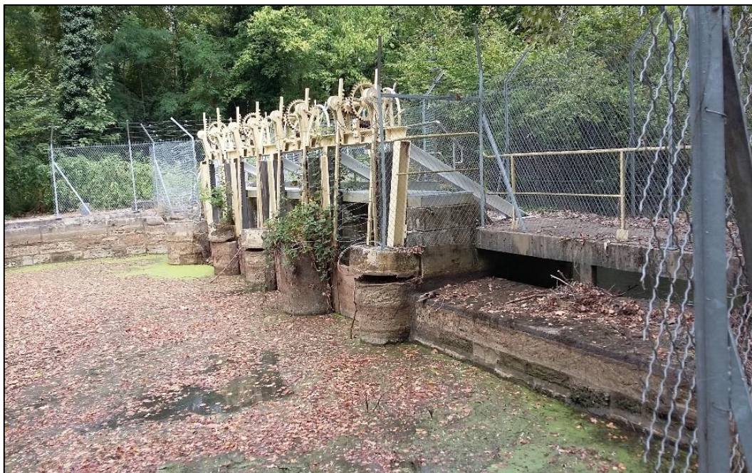
Photographie 3 : Vue amont du seuil et de ses 4 vannes (source : BURGEAP, 28/08/2019)
