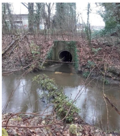
Photographie 9 : Exutoire de la canalisation EP Ø1 000 et bras annexe (source : BURGEAP, février 2020)
