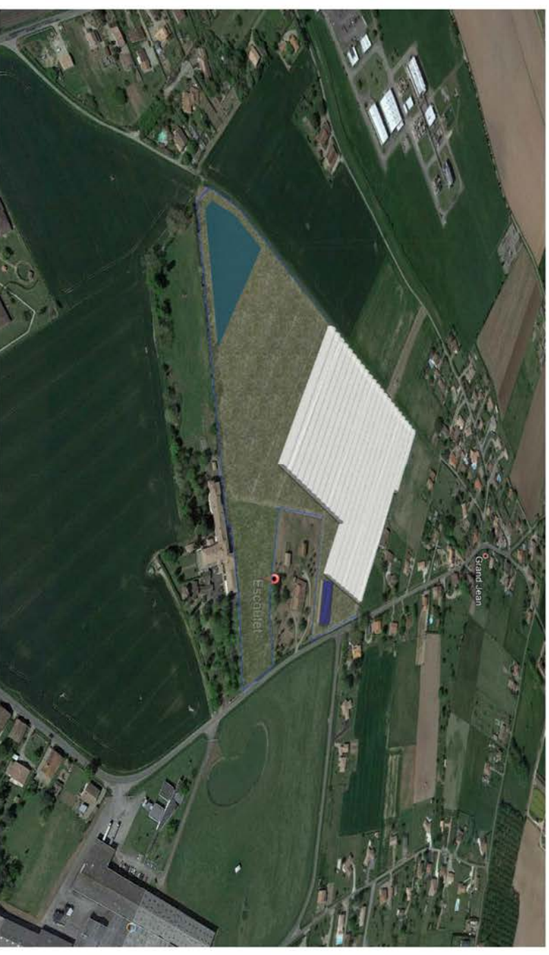
ENVIRONNEMENT APRES TRAVAUX
