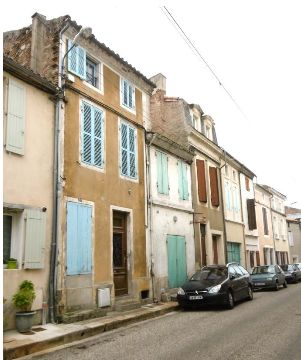
UN CARACTÈRE LOCAL A RESTAURER
