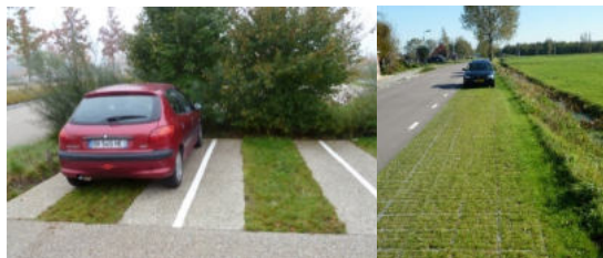
Bandes enherbées et stationnement avec système alvéolaire
