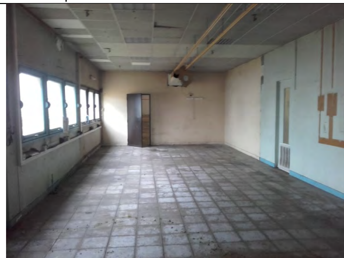
Atelier de maintenance
