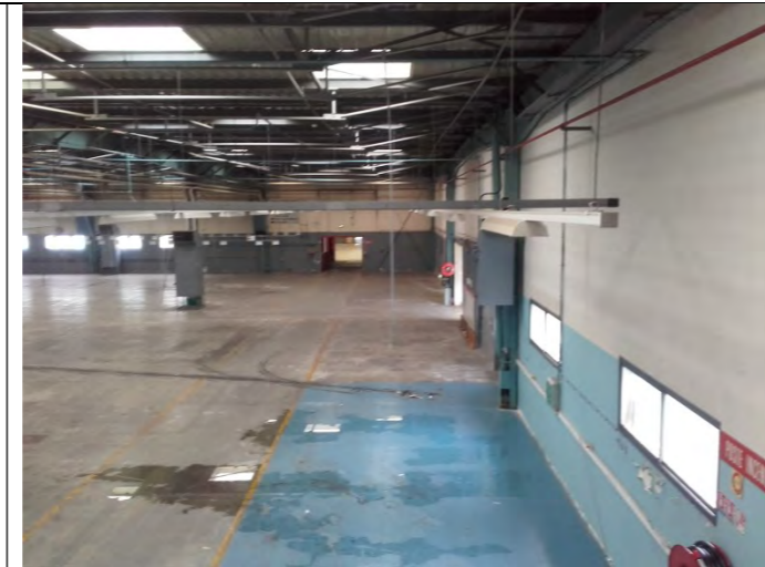
Vue générale de l'atelier depuis la coursive des bureaux
