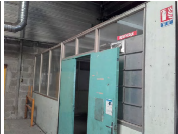
Défautheque (contrôle qualité) à l'extrémité sud-est
