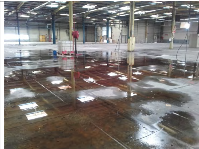
Zone souillée par de l'huile et cuve fuyarde
