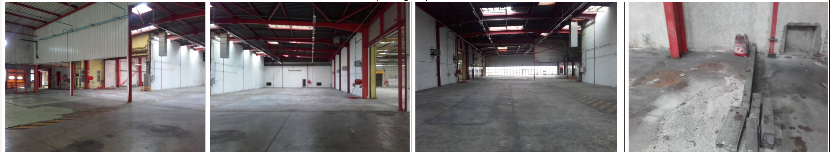
Vue des deux espaces séparés par un mur
