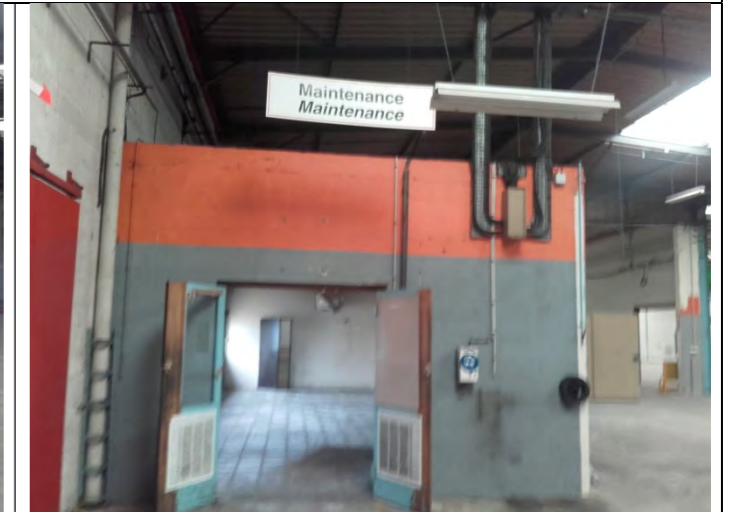
Petit atelier de maintenance
