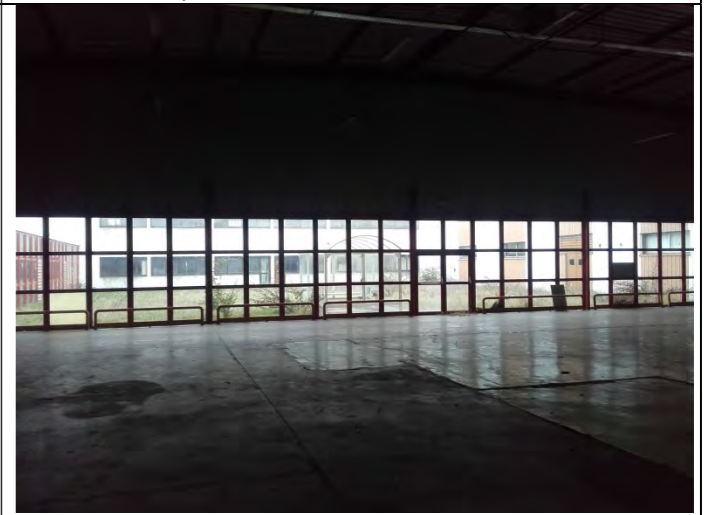
Atelier à proximité du patio
