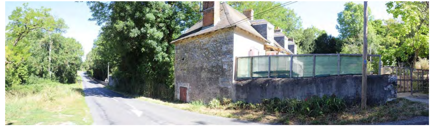
Photo 42: Des habitations sont comprises entre le périmètre du domaine partiellement inscrit-classés de la Forge et la RD8b.
