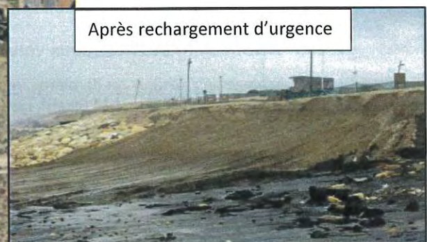
Figure 19 : Exemple de rechargement d'urgence janvier 2020. Source : Fiche travaux - Rechargement urgence Colonne CDCMA
