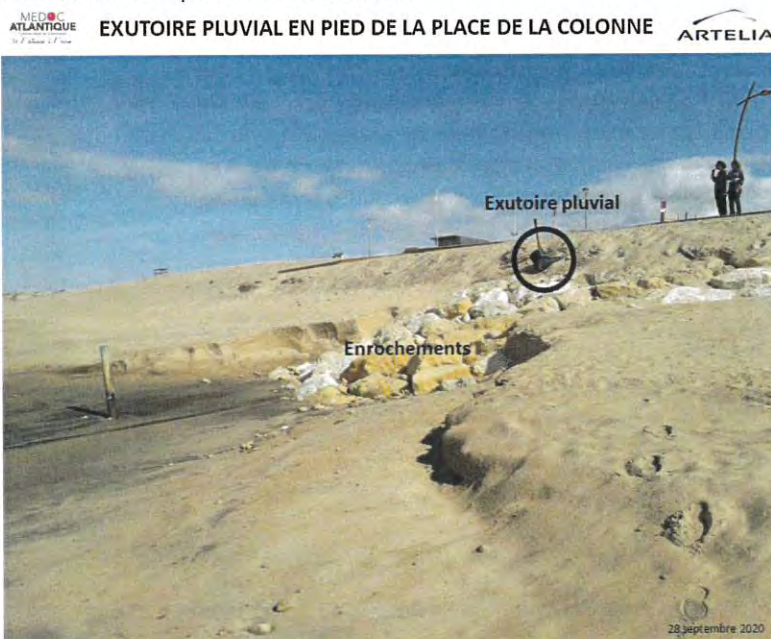
Figure 6 : Exutoire pluvial en pied de la place de la Colonne
