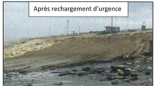
Figure 7 : Exemple de rechargement d'urgence janvier 2020. Source : Fiche travaux - Rechargement urgence Colonne CDCMA
