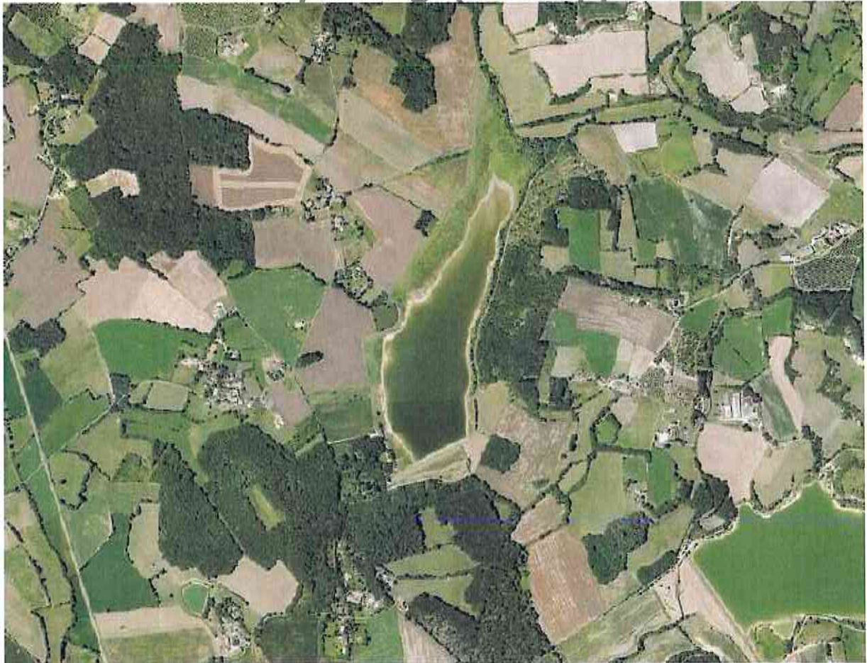
Vue aérienne du barrage de la Ganne
