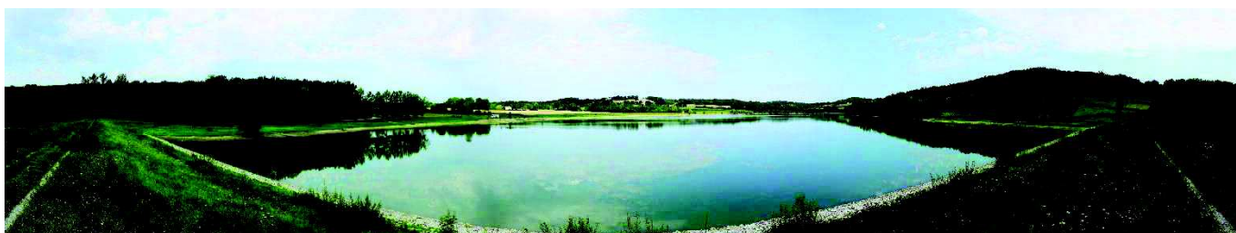
Figure 40 : [VUE 7] vue depuis la digue
