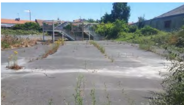
Photographie 7 : Traces d'un ancien bâtiment démoli
