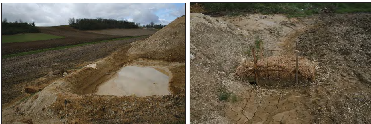
Figure 3 : bassin de décantation temporaire des eaux de ruissellement en phase de chantier avec filtre à paille en sortie
