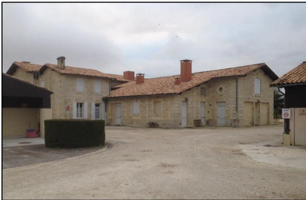
Site du projet à proximité de CPT1
