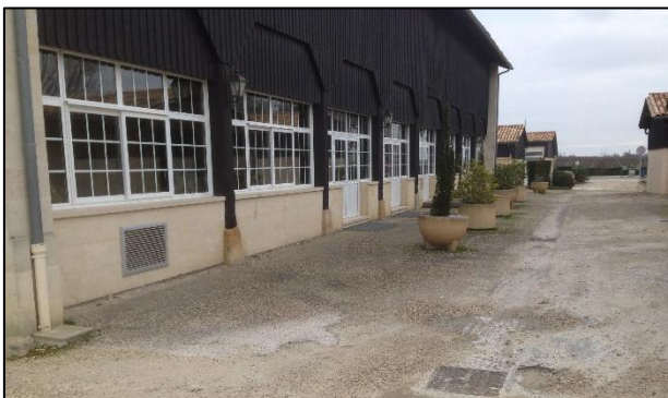
Site du projet à proximité de CPT3
