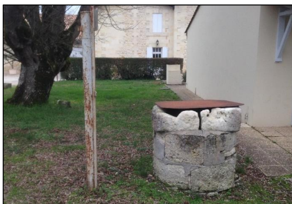
Puits existant situé à proximité de SP1+Pz
