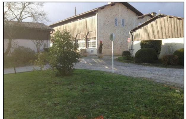
Site du projet à proximité de CPT2
