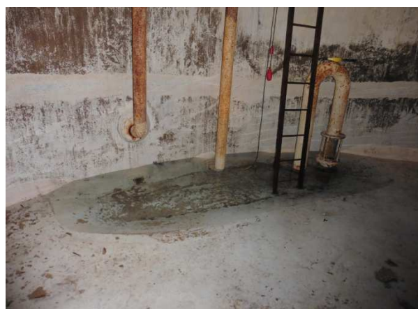
← Vues sur l'échelle d'accès et les canalisations corrodées
