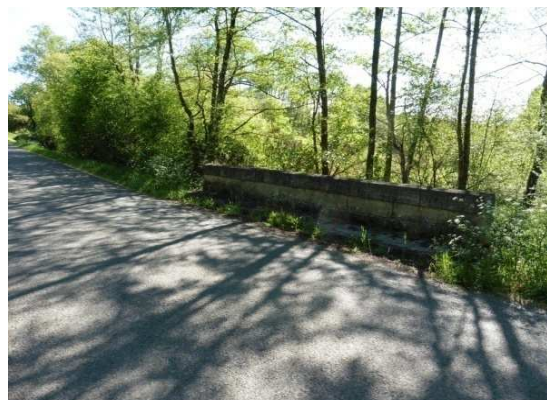
RD n° 177 : pont sur La Lizonne
