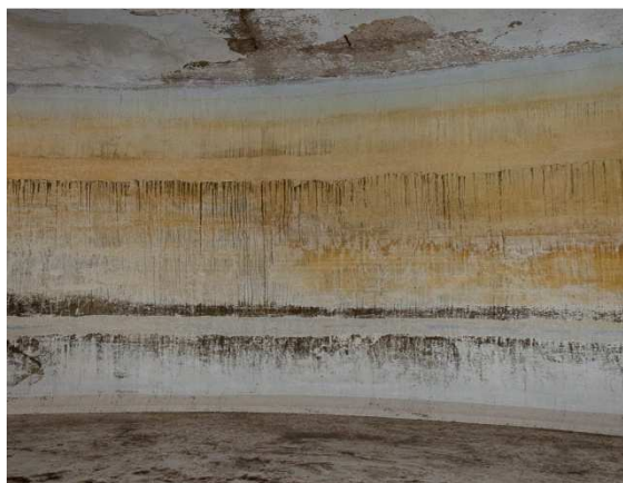
Vue sur les 2 bandes d'étanchéité périphérique
