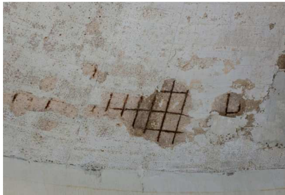
Aciers corrodés apparents sous l'intrados de la coupole
