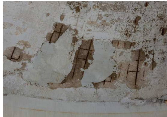
Aciers corrodés apparents sous l'intrados de la coupole
