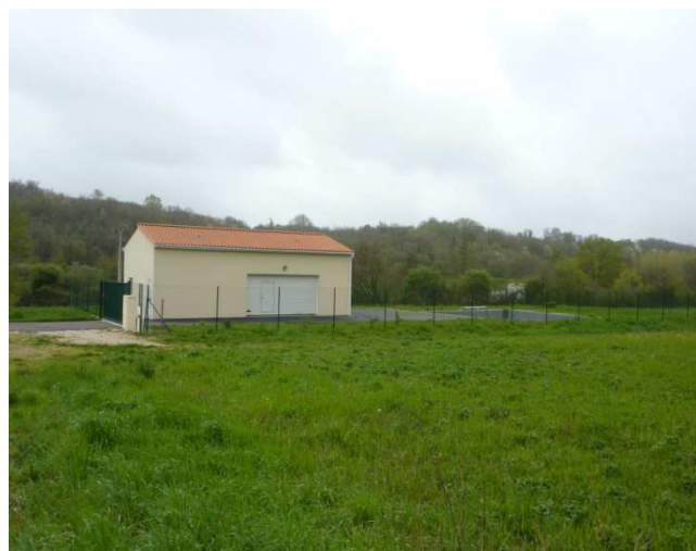
Station de traitement de Puyménard
