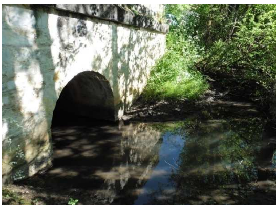
RD n° 177 : pont sur La Lizonne
