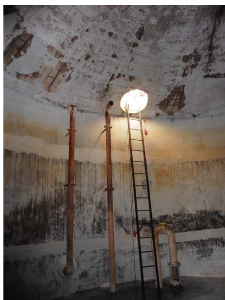
← Vues sur l'échelle d'accès et les canalisations corrodées
