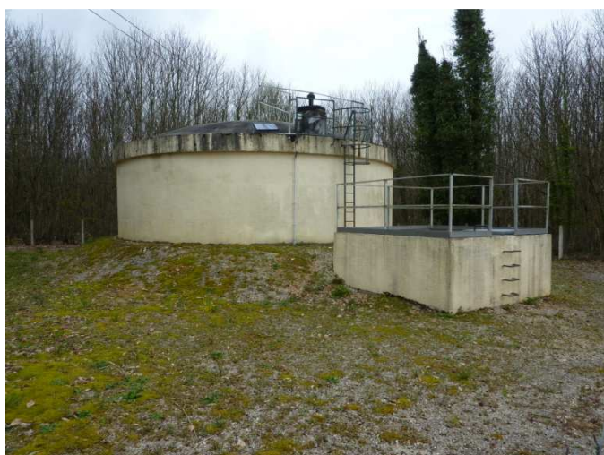
Réservoir au sol du Morinet
