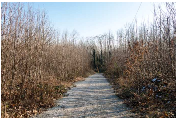
Chemin desservant le réservoir Le Morinet
