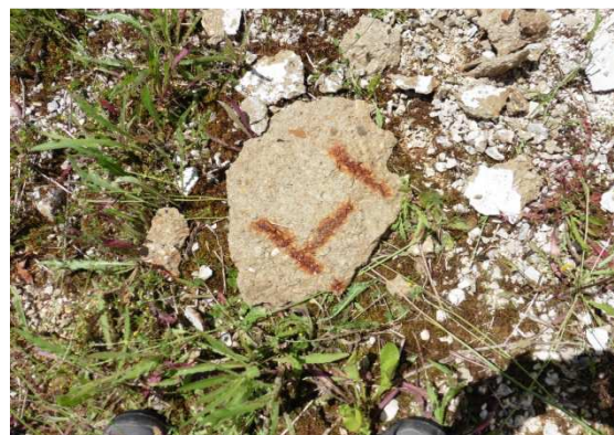
Morceaux de béton tombés de la coupole
