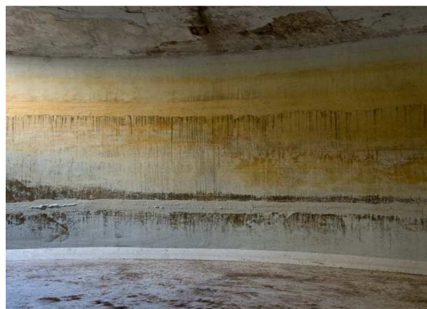
Vue sur les 2 bandes d'étanchéité périphérique
