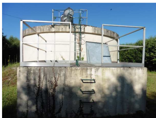
Chambre de vannes vue extérieure
