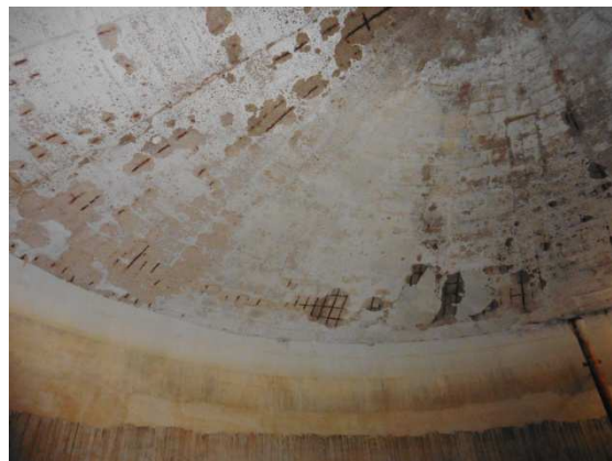
Vue sur intrados coupole et aciers apparents
