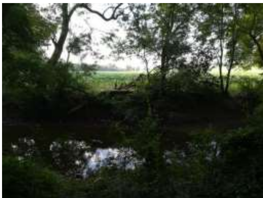
Passage dans la Tardoire par forage dirigé
