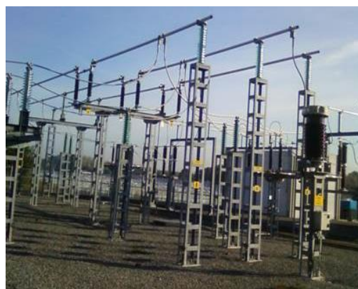
Illustration 11 : Exemple de jeu de barres
