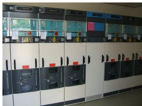
Illustration 8 : Exemple de tableau HTA
