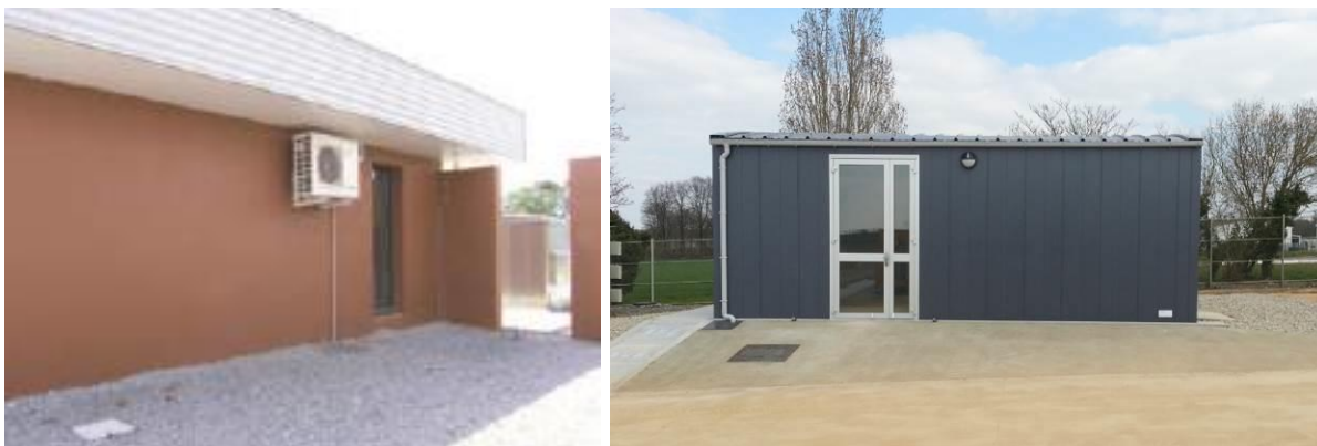
Exemple de bâtiments d'un poste de transformation
