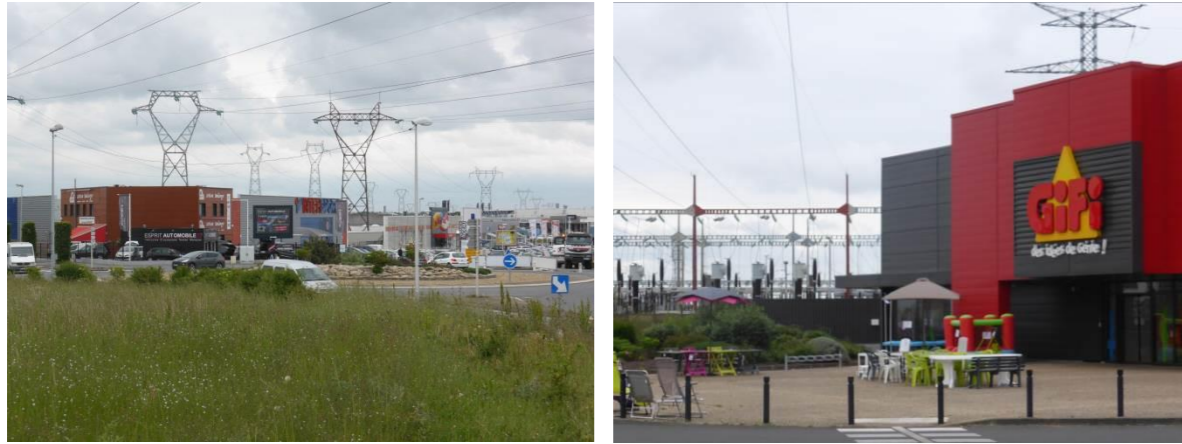
Illustration 33 : Zone commerciale de Beaulieu – En arrière-plan le poste électrique de BEAULIEU
