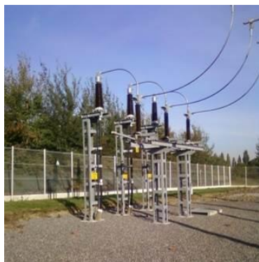
Illustration 13 : Exemple de raccordement d'un poste par liaison souterraine au réseau Rte
