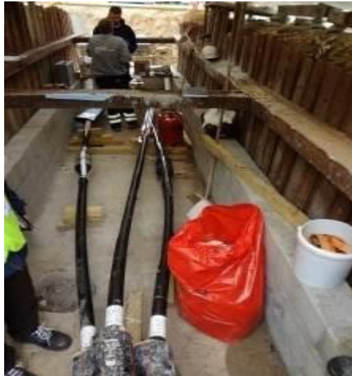
Illustration 18 : Exemple d'une chambre de jonction
