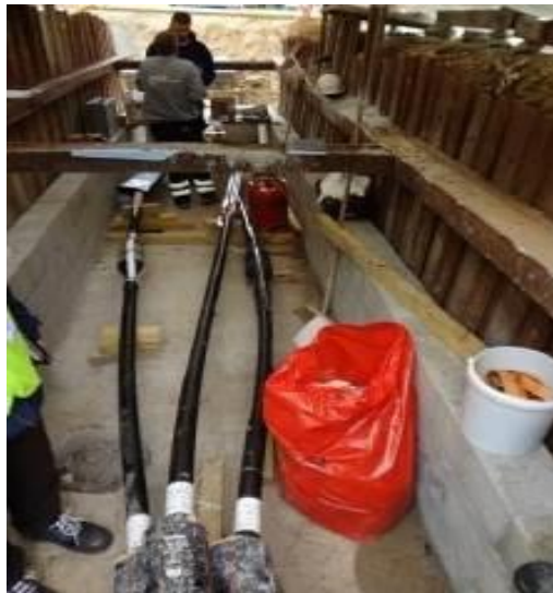
Illustration 21 : Exemple d'une chambre de jonction
