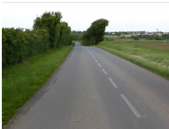
Illustration 38 : Voie d'accès à la RD105, au nord du Fief des Nouvelles (vue vers le nord)
