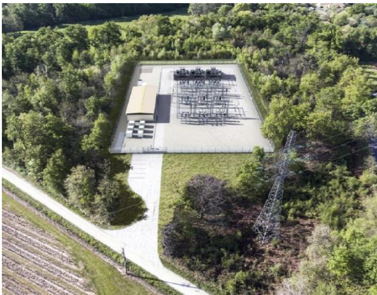
Exemple de poste de transformation
