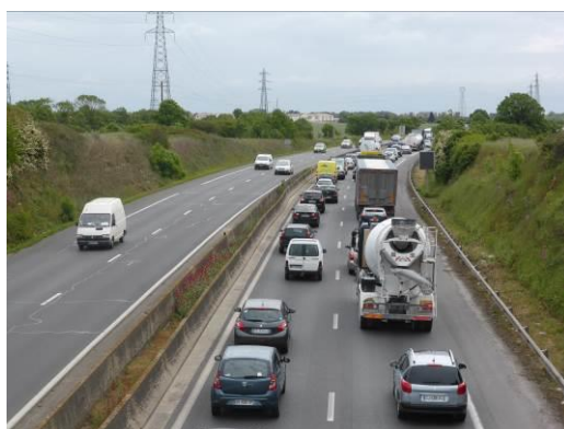
Illustration 36 : La RN237 (vue vers l'est) depuis le passage supérieur de la voie communale entre le Fief des Couardes et la Descenderie
