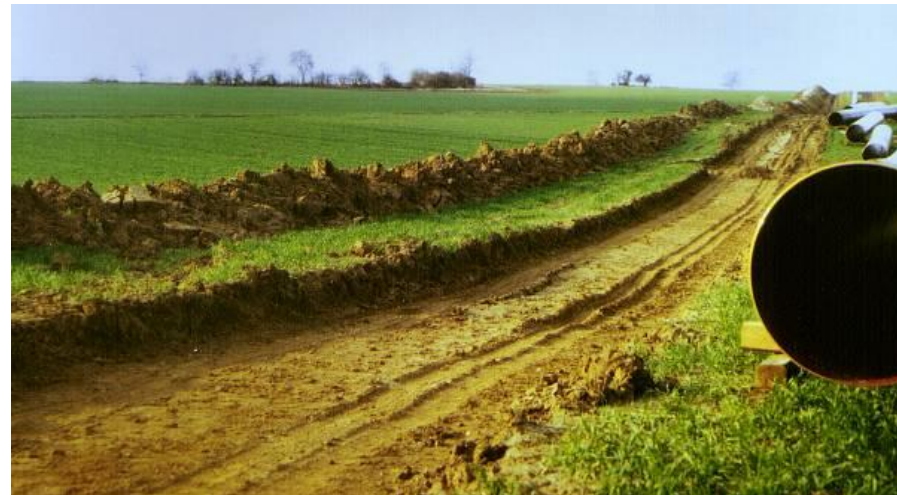
Photo 13 : Décapage de la terre végétalisée de la future tranchée
