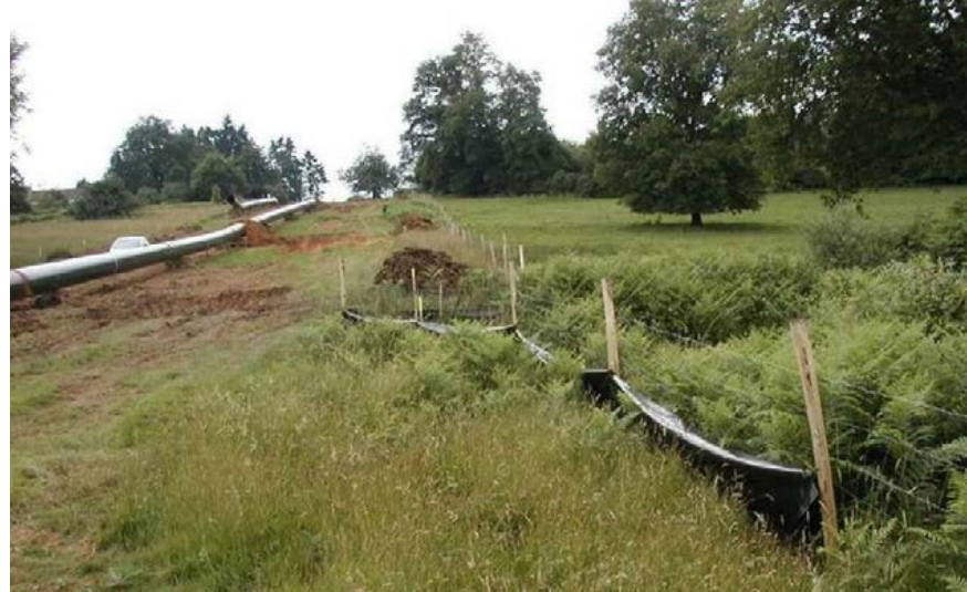
Photo 4 : Pose de clôtures provisoires le long de la piste
