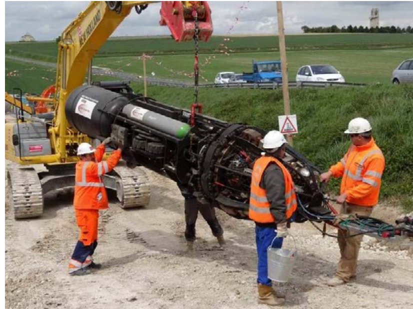
GRTgaz (chantier Hauts de France) – 2013
