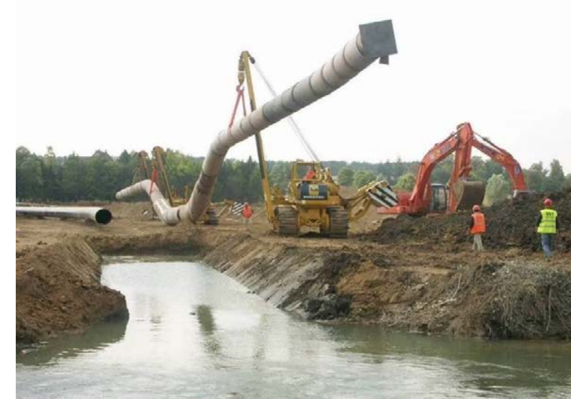
Photo 15 : Franchissement en souille, mise en place de la pièce
