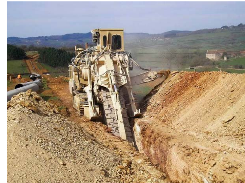
Photo 14 : Ouverture de la tranchée
