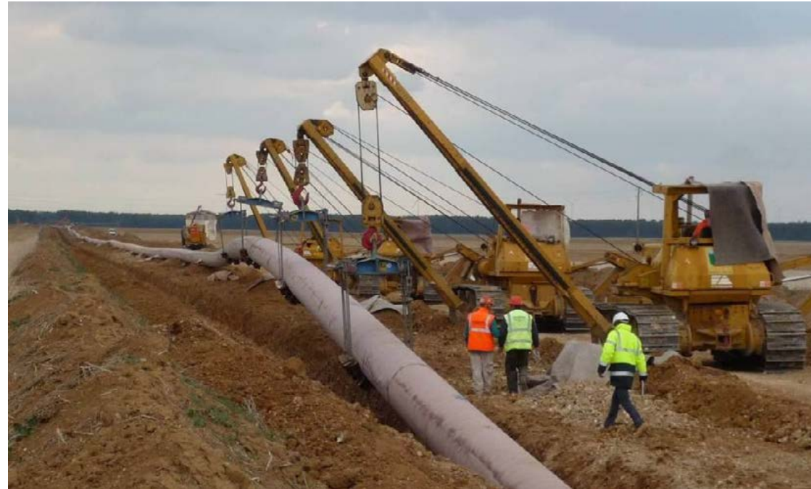
Photo 21 : Mise en fouille par les sidebooms
