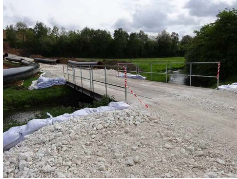
Photo 2 : Pont provisoire
