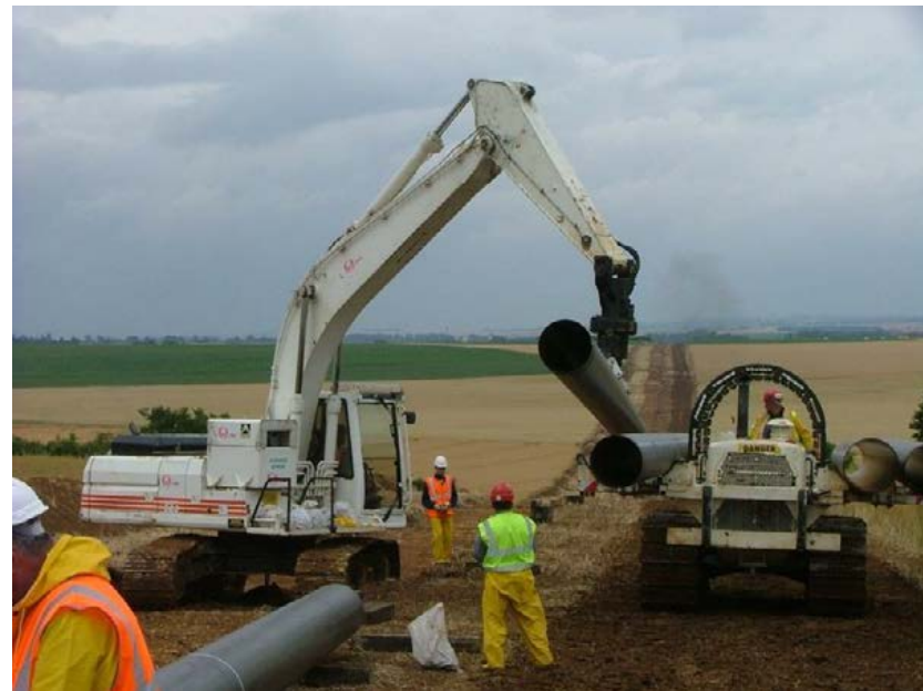
Photo 7 : Bardage des tubes
