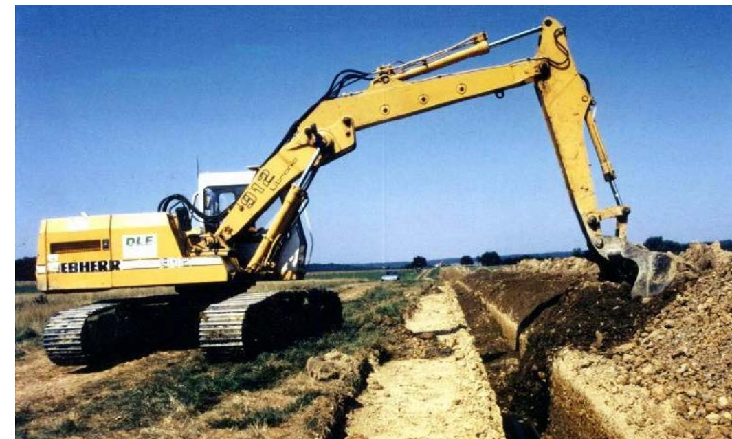
Photo 22 : Remblaiement
