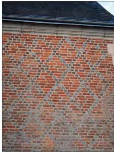
Détails décoratifs dans l'appareillage, losanges de briques
