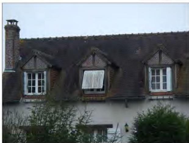
Couverture en tuiles plates, lucarnes jacobines, frontons en pan de bois à remplissage brique
