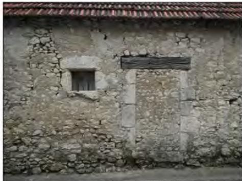
Façade remaniée, moellons de calcaire, encadrement en pierre de taille ou gros appareil, linteau bois
