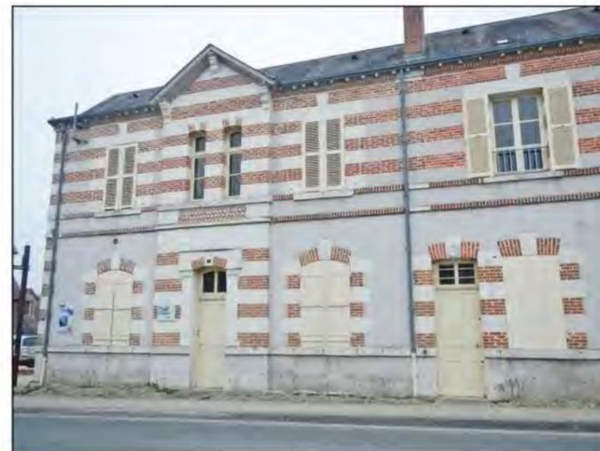
Ecole construite au XIX<sup>ème</sup>, équipement en R+2, construction mixte pierre et briques, couverture en ardoise
