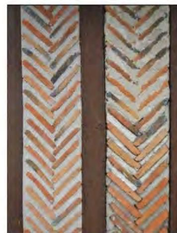
Pan de bois à remplissage en chantignolle disposée en arête de poisson
