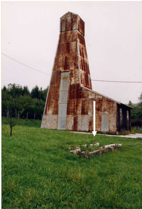
Figure B- 15 : Localisation présumée du sondage S2 (1991)
