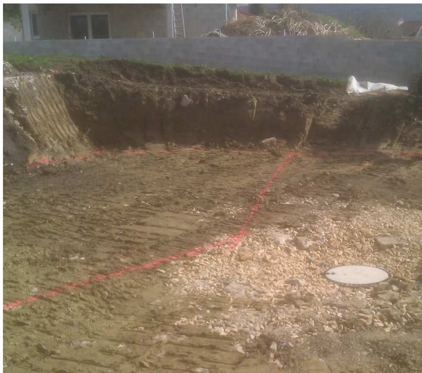
Figure B- 14 : Etat du site après comblement de l'avant puits et réaménagement (colonne de viroles béton et tampon fonte à l'avant à droite)
