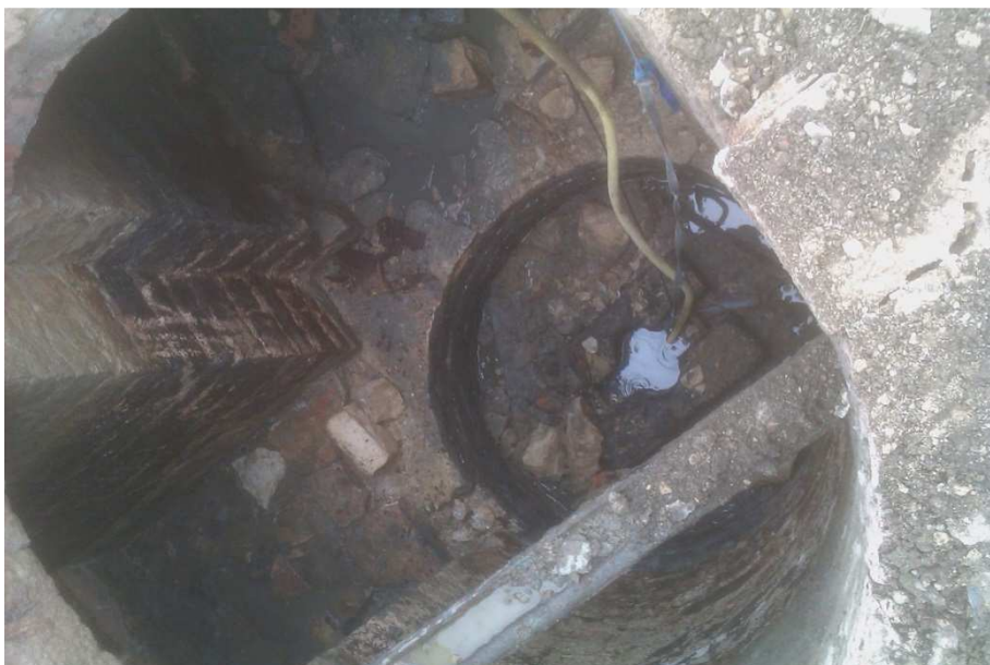
Figure B- 13 : Etat de l'avant puits après assèchement et curage de la boue (vue du haut)
