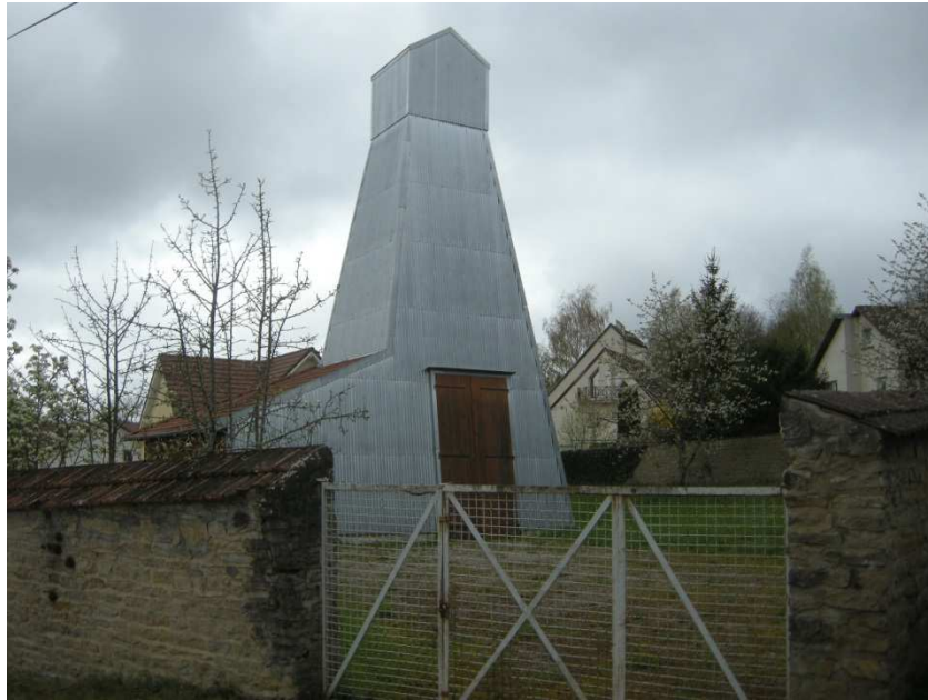
Figure B- 20 : Localisation et état du sondage S5 (2016)
