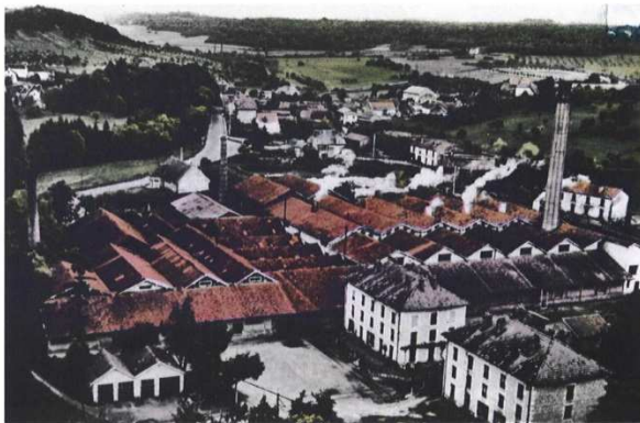
Figure B- 1 : Vue générale de la saline de Miserey en fonctionnement
