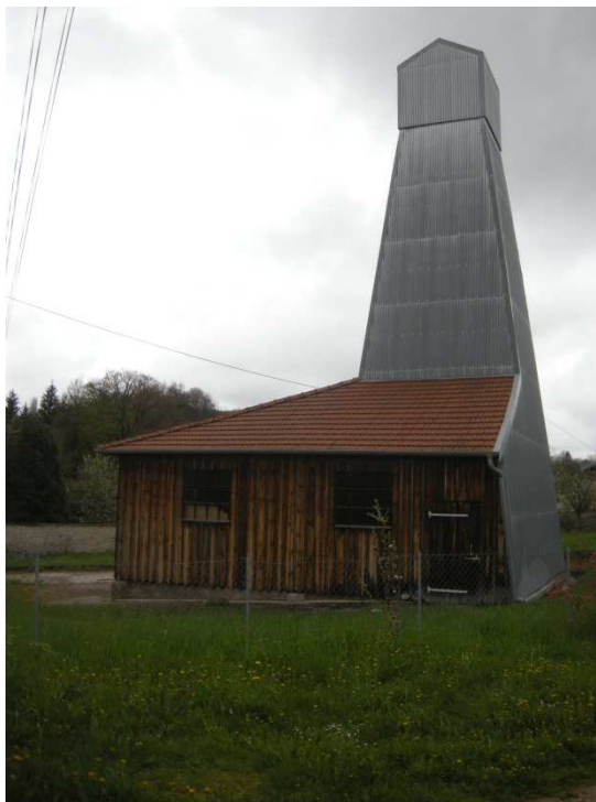
Figure B- 19 : Etat du sondage S3 (2016)
