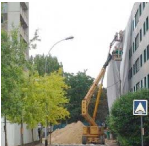
Bachage des façades environnantes en vue de la démolition
