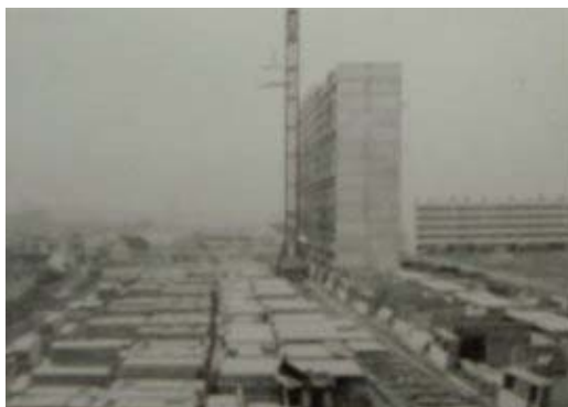
Chantier aux 4000 sud © IGN
