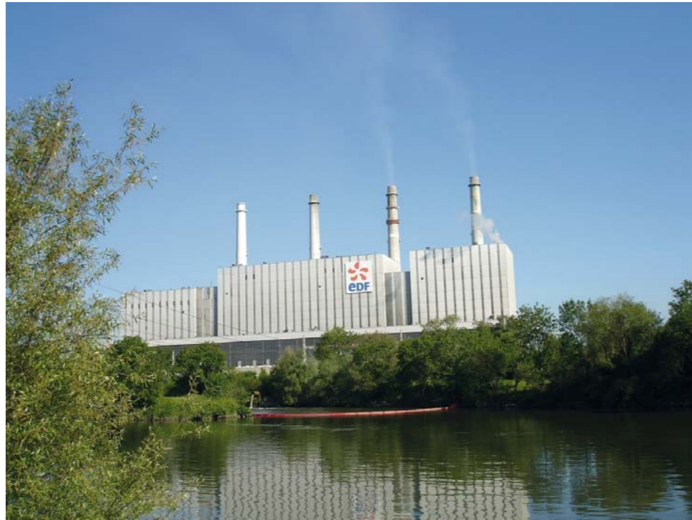
Photo Air EDF centre de production thermique de Blénod [54]
