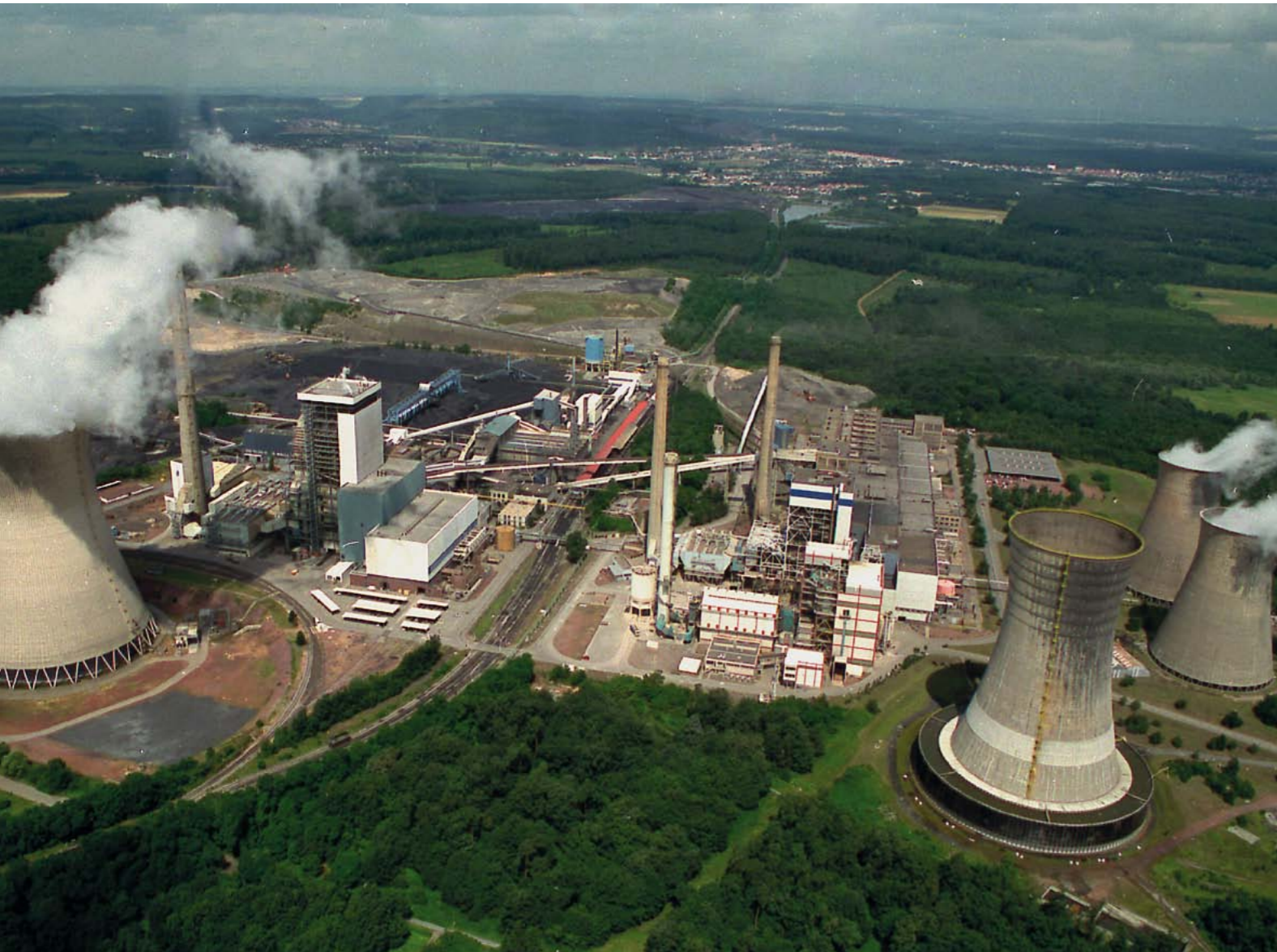
Centrale thermique EON à Carling [57]
