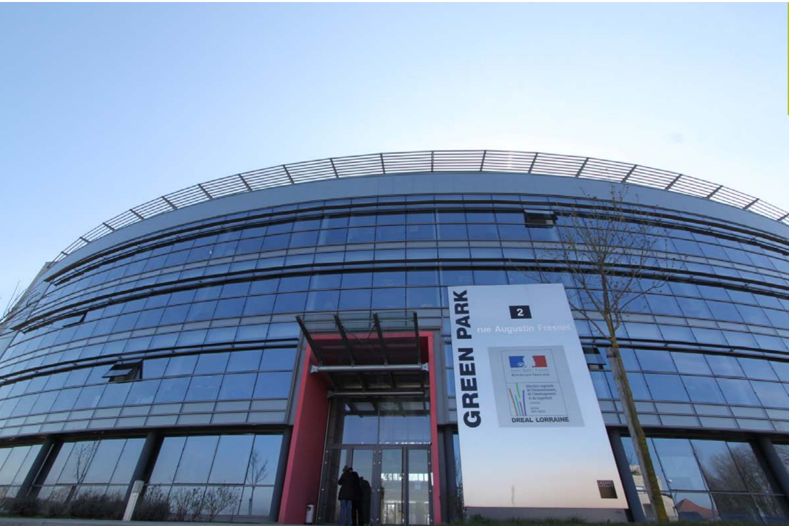
Bâtiment GREEN Park, siège de la DREAL Lorraine
