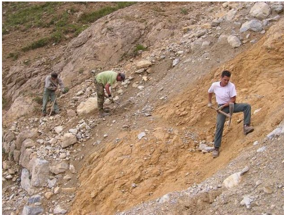
Remise en état et entretien de sentiers (ONF, B. Guédon)
