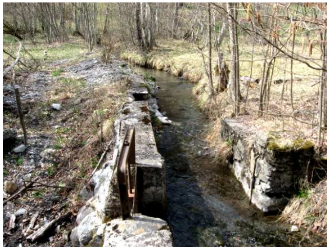
Prise d'eau du canal de Valbonnais sur la commune du Périer (photo :P.Mayade)
