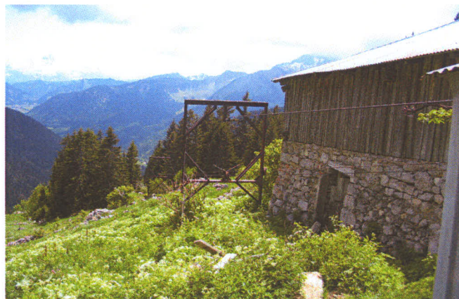
Arrivée de câble à l'alpage de Cheneau
