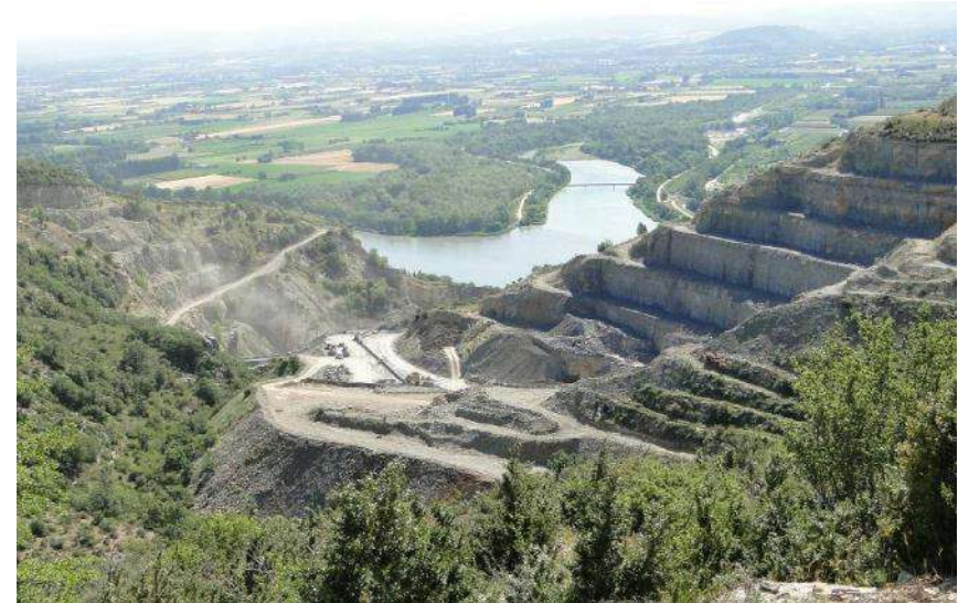
Carrière de Le Pouzin exploitée par Lafarge Granulats, vue du plateau de Rompon (© Biotope, 2012)
