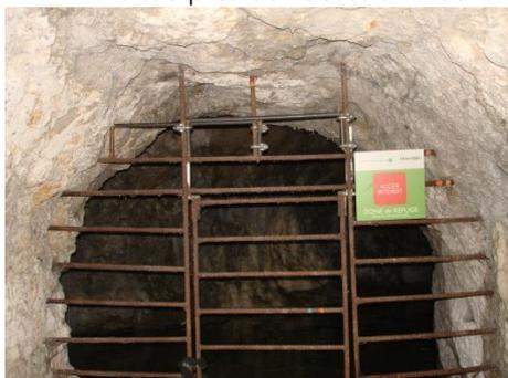
Photo 103 : grille à barreaux horizontaux posée en 1998. panneau réglementaire (oct. 2009) et ajout d'un barreau en partie supérieure (2012). (©RL/LPO).
