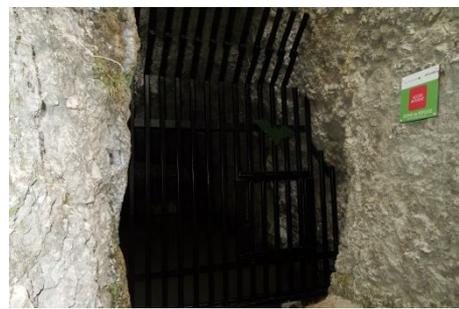
Photo 108 : grille réalisée à l'accès aval de la galerie fin août 2017(©RL/LPO).
