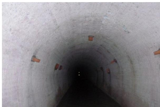
Photo 56 : Partie bétonnée de la galerie et briques creuses offrant des loges pour la barbastelle (©RL/LPO-RA).
