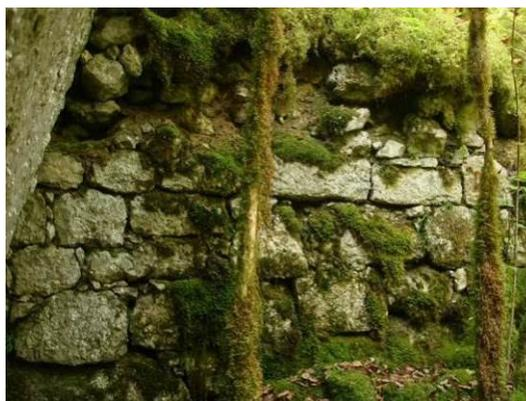
Photo 90 : Certains murs de soutènement du chemin faisaient également office de mur de bâtiment, en contrebas (©RL/LPO).
