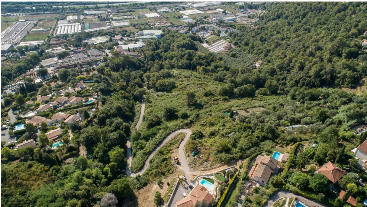
Figure n°2 : Vue d'ensemble du projet depuis l'Ouest (Août 2019)
