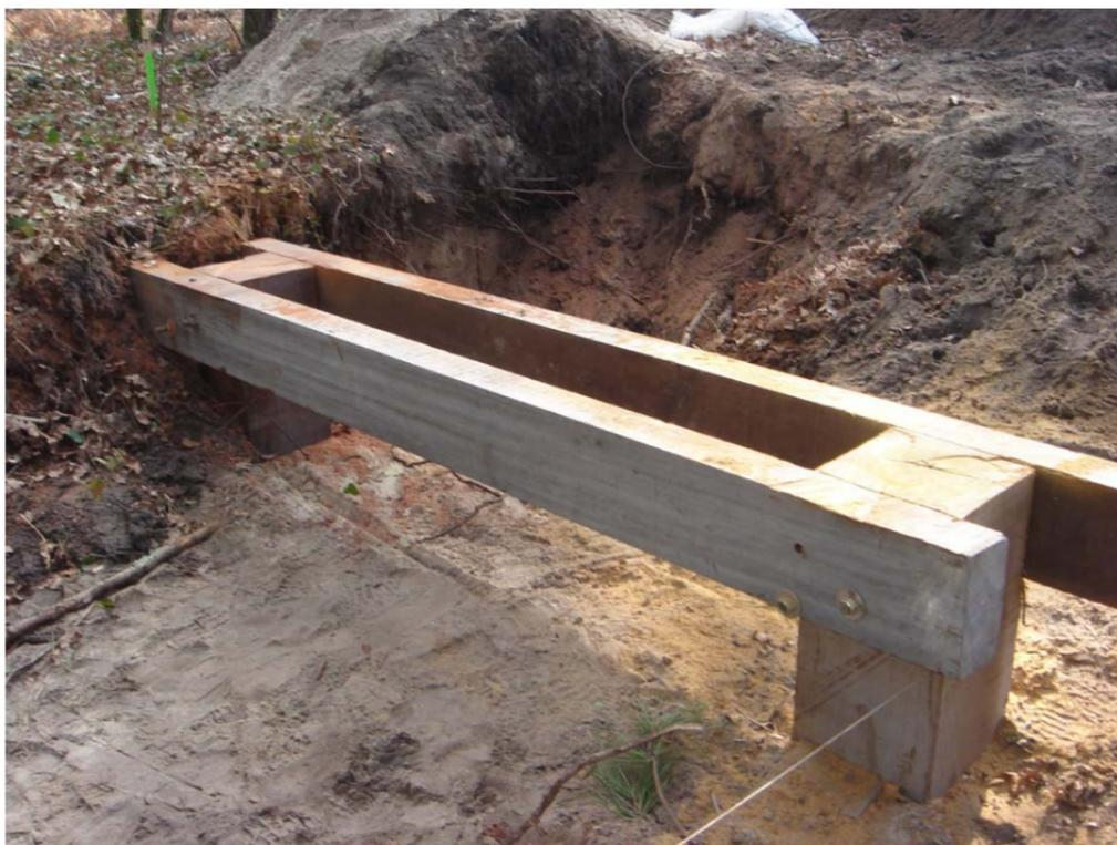
Exemple de palée culée mise à niveau pour appui passerelle (14 x2ml)
