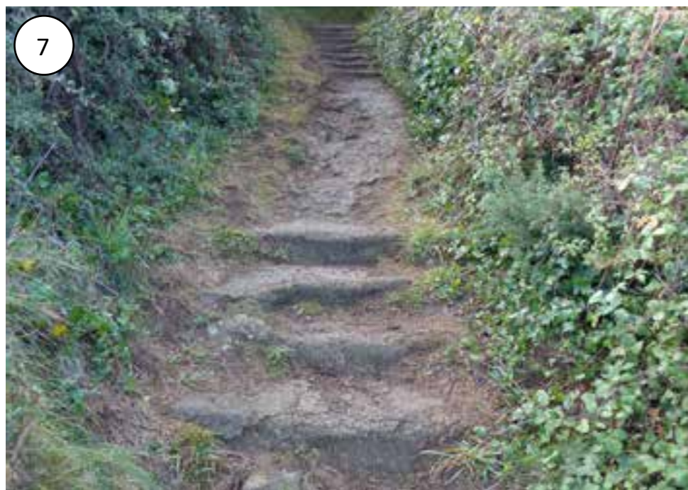
Cheminement et emmarchements à requalifier
