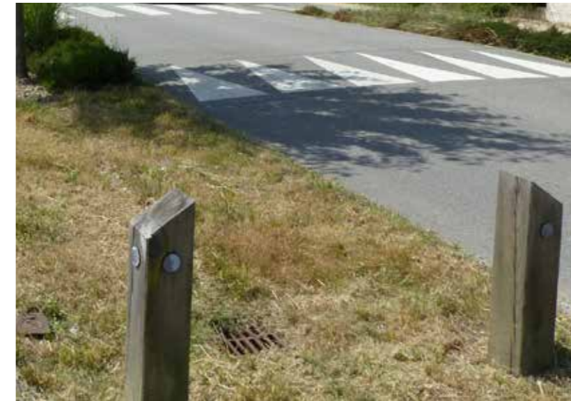
Potelet bois fixe et amovible / entrée site
