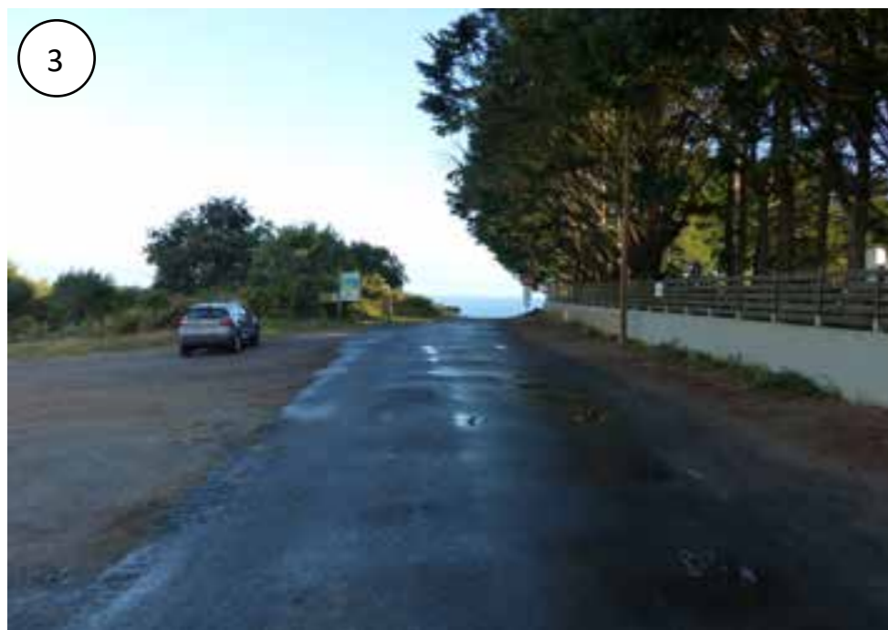
Parking actuel à renaturer et voirie en enrobé à remplacer par un cheminement en stabilisé
