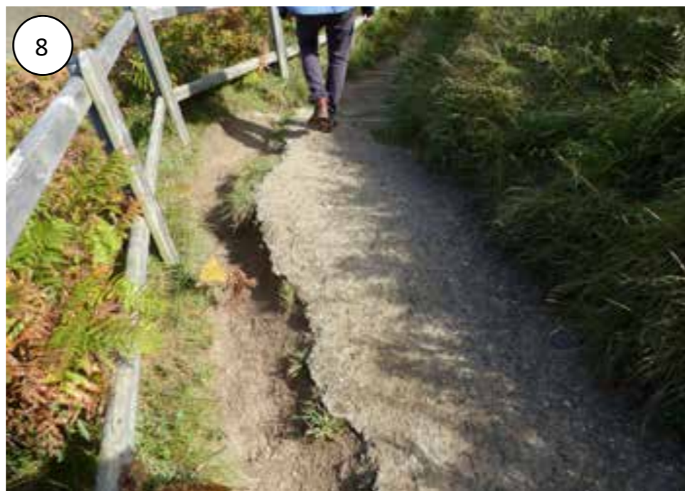
Cheminement à requalifier
