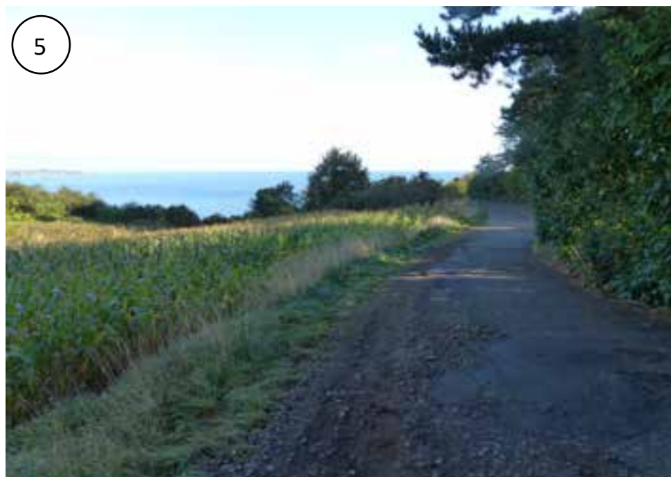
Voirie en enrobé qui sera remplacée par un cheminement en stabilisé
