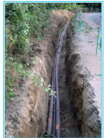
Figure 9 : tranchée avec fourreau PEHD
