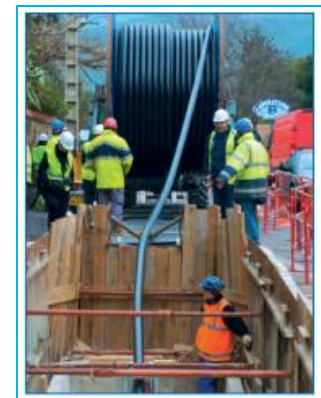
Figure 7 : déroulage d'un câble souterrain sur bobine
