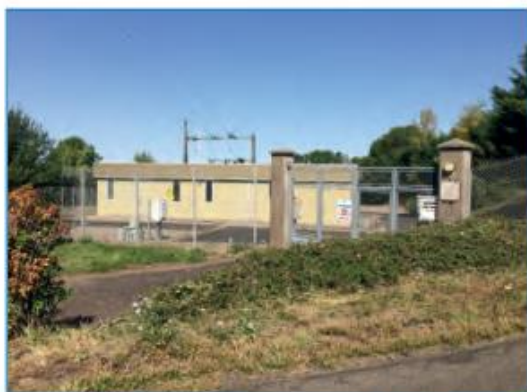
Poste existant de SAINT-PIERRE-ROCHE
