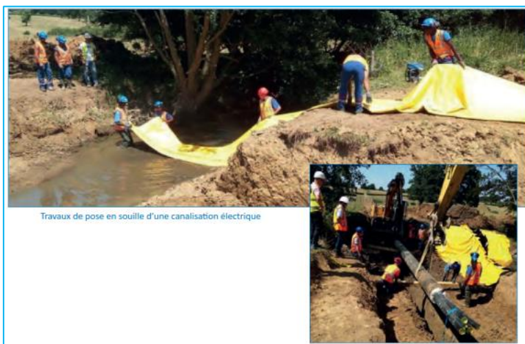
Figure 13 : travaux de pose en souille d'une canalisation électrique
