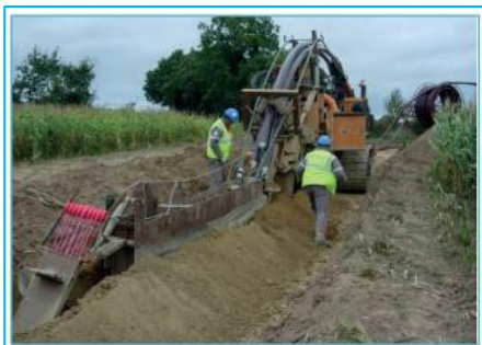
Figure 11 : pose de fourreau PEHD en zone agricole à l'aide d'une trancheuse
