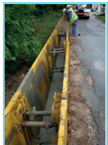
Figure 10 : bloc fourreau PVC
