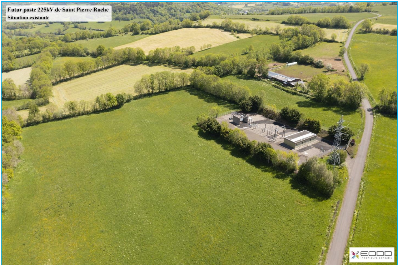
Figure 30 : vue aérienne du site actuel
