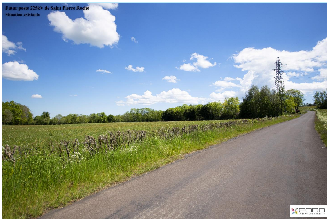
Figure 33 : vue du site actuel depuis la route départementale
