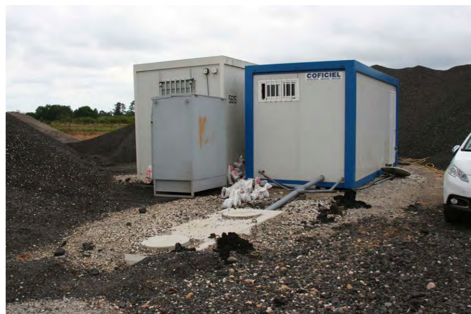
Base vie Local pour le personnel et sanitaires équipés d'un assainissement autonome
