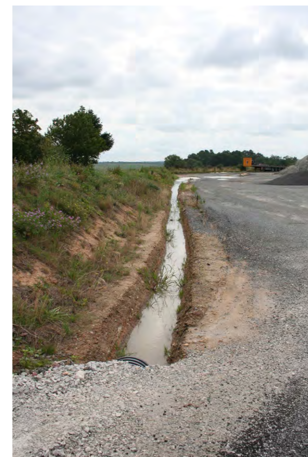
Fossés de collecte des eaux de ruissellement
