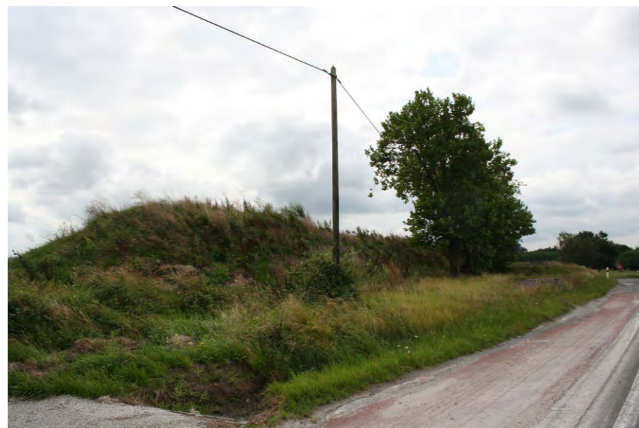
Merlon périphérique réalisé avec les matériaux de décapage
