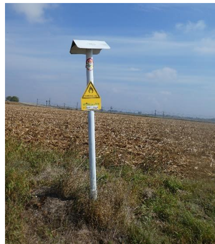
6 - Signalisation de l'oléoduc traversant le secteur
