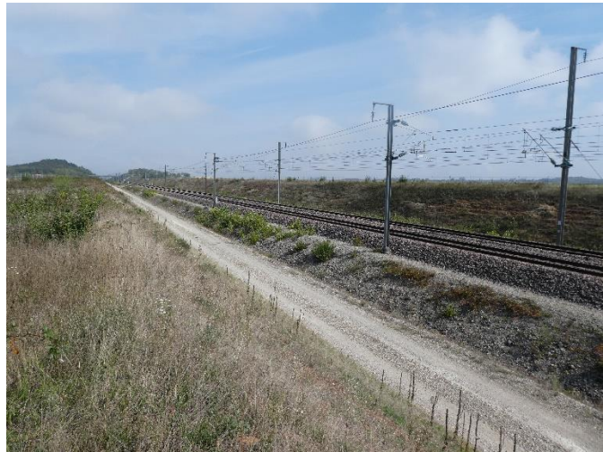
2 - Chemin d'exploitation de la LGV et talus à franchir vers le secteur envisagé
