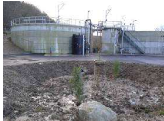
Silo à boues
