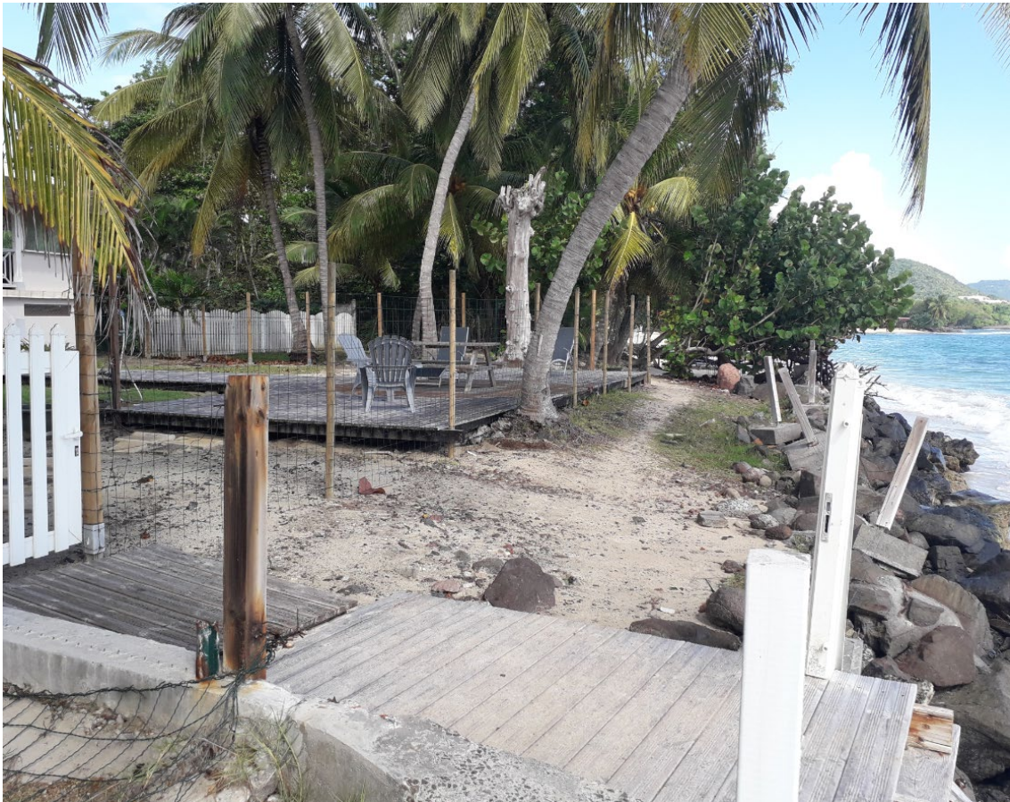
Figure 16 : Cheminement existant parcelle K161 et ouvrage en béton sur escalier existant (Source : SUEZ CONSULING, 2020)
