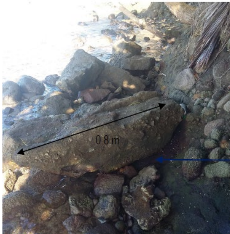
Figure 25 : Bloc rocheux en pied de falaise (Source : Ginger Géode)
