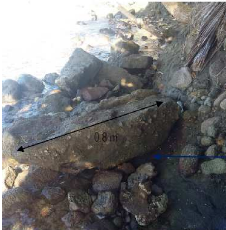
Figure 26 : Bloc rocheux en pied de falaise (Source : Ginger Géode)
