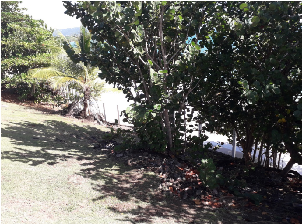
Figure 12 : Remodelage du terrain (Source : SUEZ CONSULTING, 2020)
