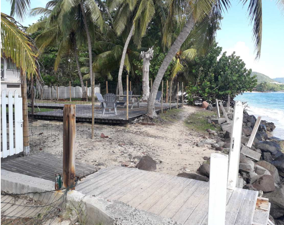
Figure 16 : Cheminement existant parcelle K161 et ouvrage en béton sur escalier existant (Source : SUEZ CONSULING, 2020)
