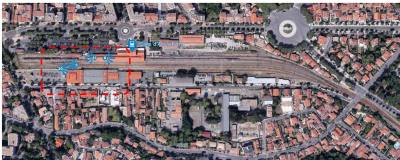
Photo 7 : Localisation des prises de vue - fond de gare
