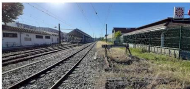
Photo 10 : Extrémité Voie de Service 5 (en heurtoir)
