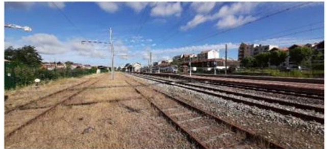
Photo 6 : Voies de services (7-5-3)
