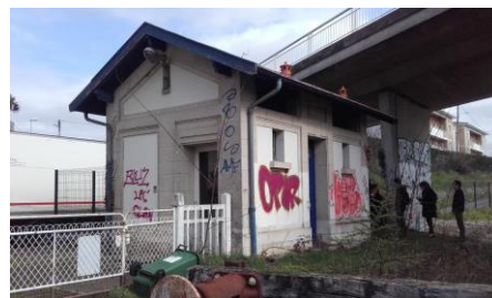
Ancienne annexe vue depuis les voies
