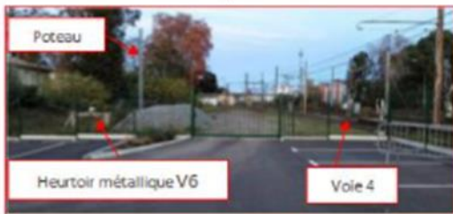
Photo 5: Vue du parking - direction Bordeaux
