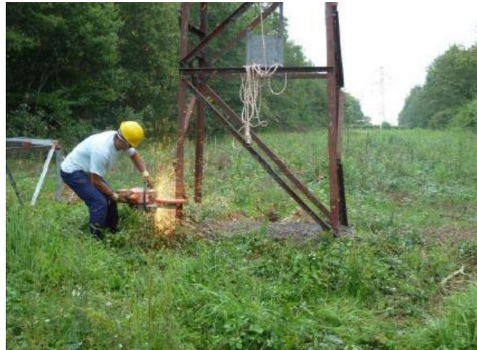
Figure 3 : Découpe des montants du pylône
