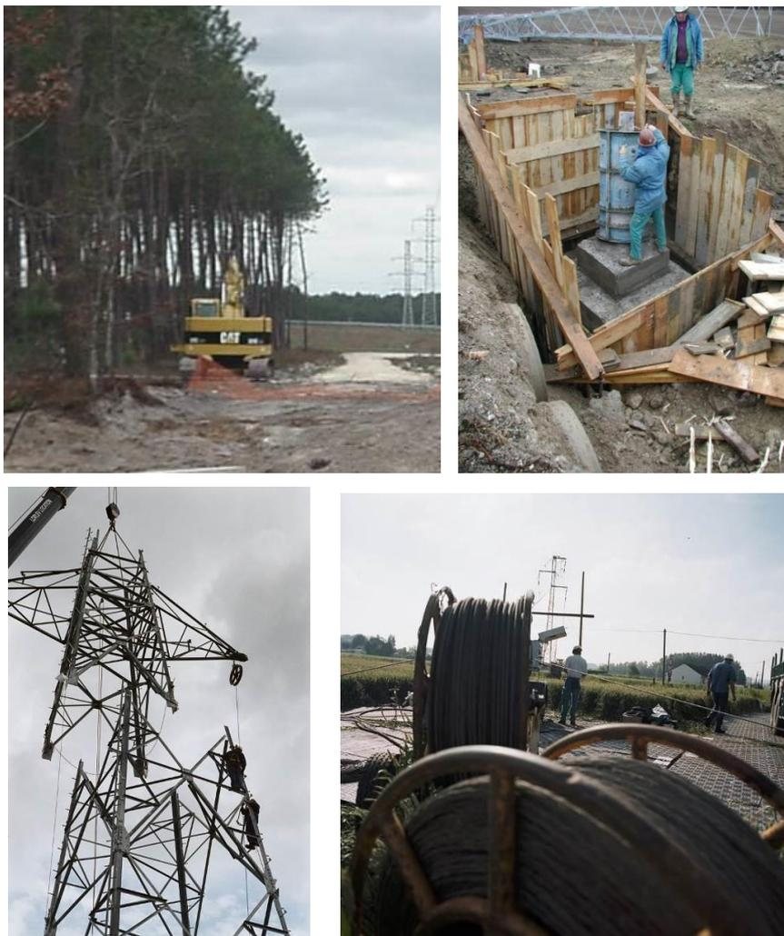
Réalisation de fondations, levage de tronçons de pylônes et déroulage de câbles
