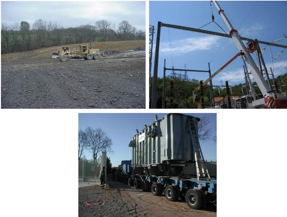
Travaux de construction d'un poste électrique (nivellement, génie-civil et montage de charpentes métalliques, installation d'un transformateur
