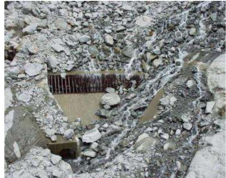
Exemple de protection de captage aérien du Tour (Emosson)
