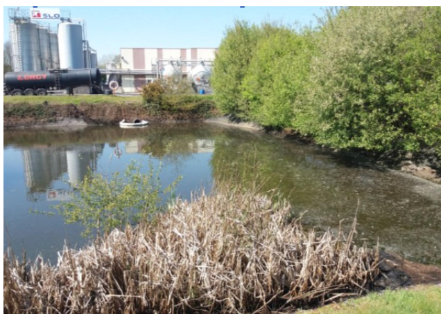
Bassin d'eau pluvial sur le site d'Eurovia
