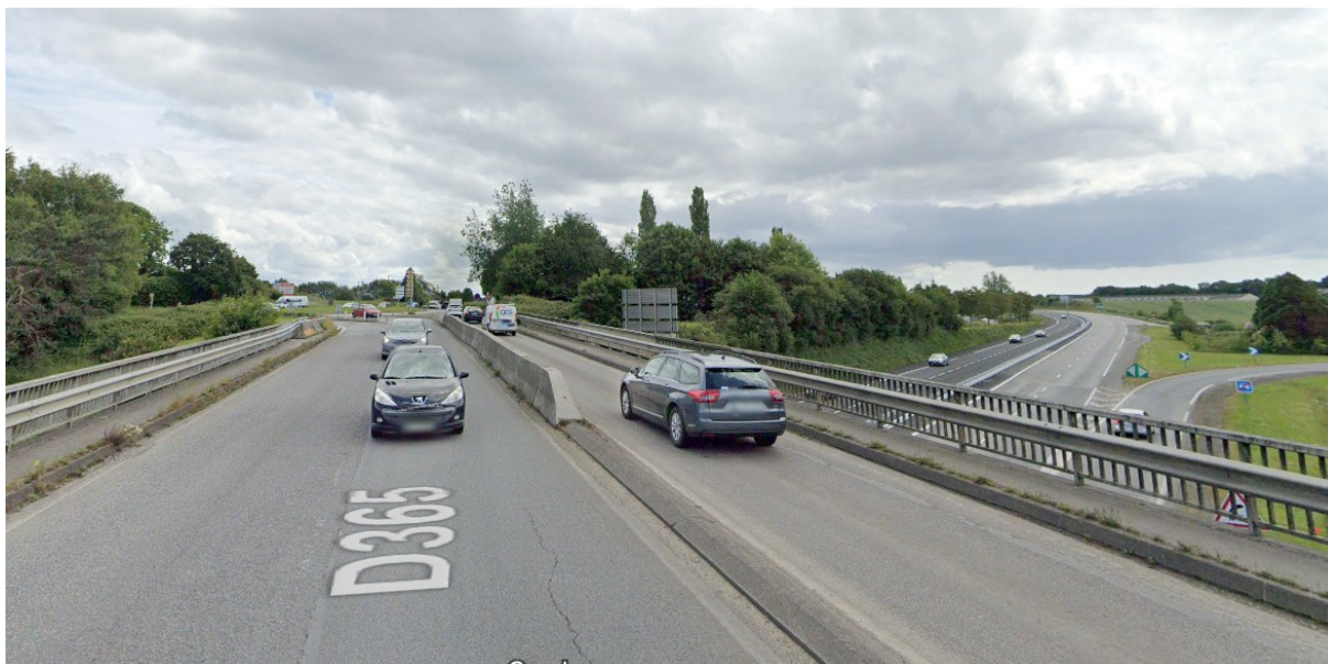
Photo 2 : Franchissement de la RN 165 par la RD 365 avant son arrivée sur le giratoire Est de l'échangeur (vers Rosporden)
