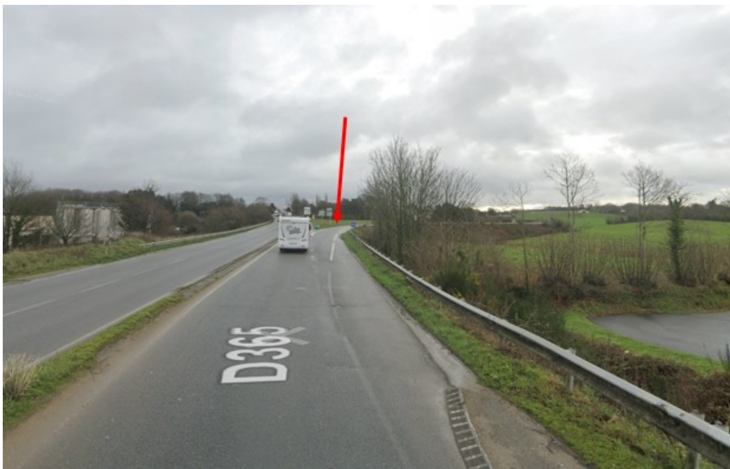
Photo 5 : Une seconde voie est prévue en sortie de ce giratoire pour relier la bretelle d'entrée sur la RN 165 (vers Lorient, cf. flèche) permettant ainsi d'augmenter le débit du giratoire
