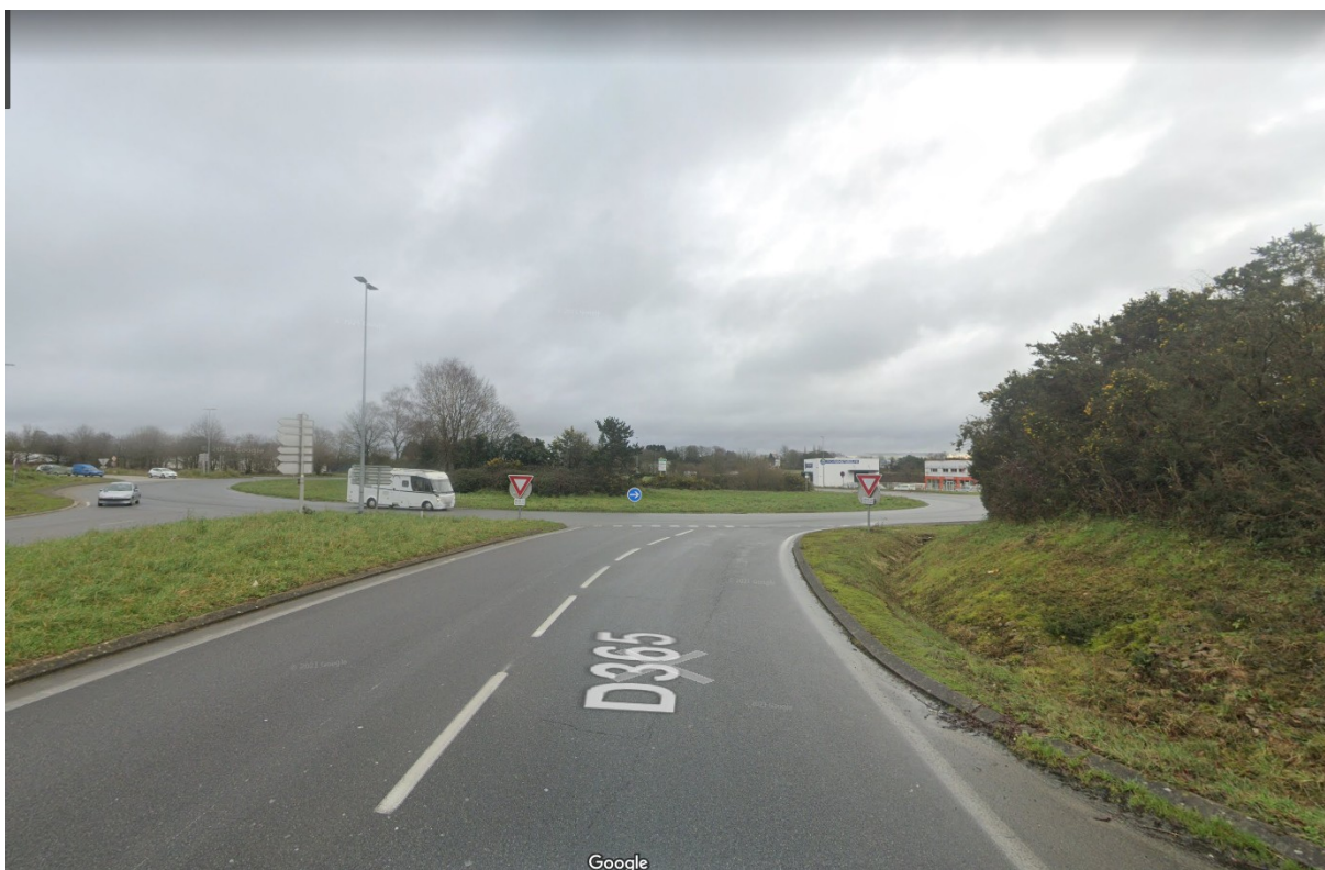
Photo 3 : Rond-point de Troyalac'h (giratoire Ouest de l'échangeur) dans le sens Quimper – Rosporden
