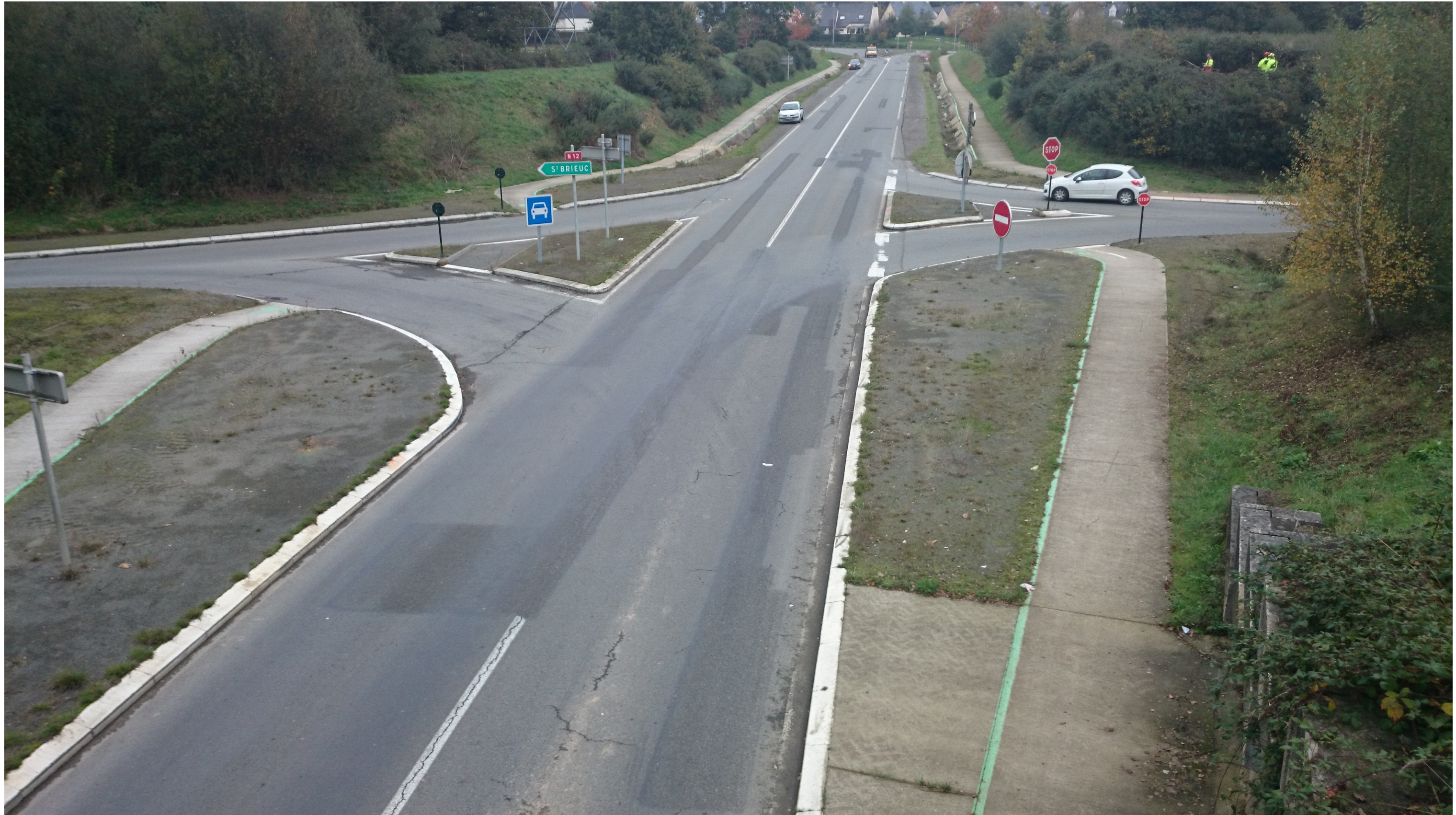
Vue sur le carrefour depuis l'ouvrage de la RN12
