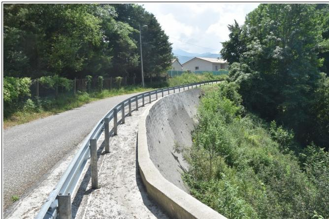
Figure 3.46: Glissement de terrain au droit de la maison de retraite et mur de soutènement confortant la RD210.
