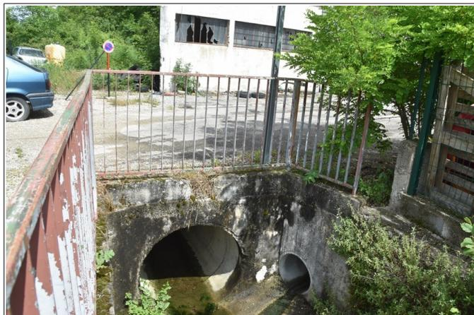
*Figure 3.29: ruisseau de Raissac au niveau de la Cité Lakanal. On notera la buse de rejet d'eaux pluviales sur la droite.*
