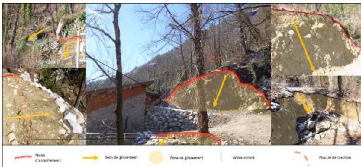
Figure 42 : Glissements générés par érosion à proximité des ravines entre Bégis et L'Espladou (source : AGERIN SAS )
