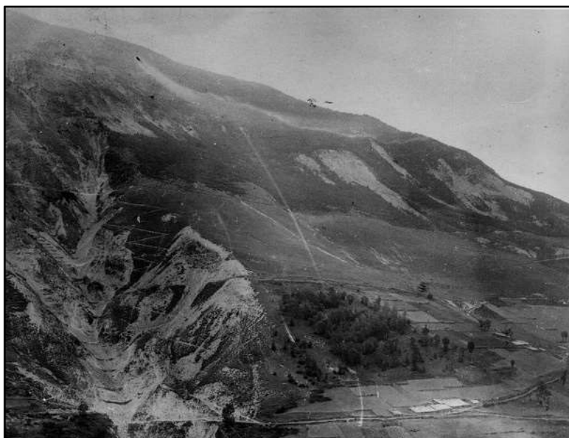
Figure 20 : Ravin du Gravel L'Artigues (source : service RTM)
