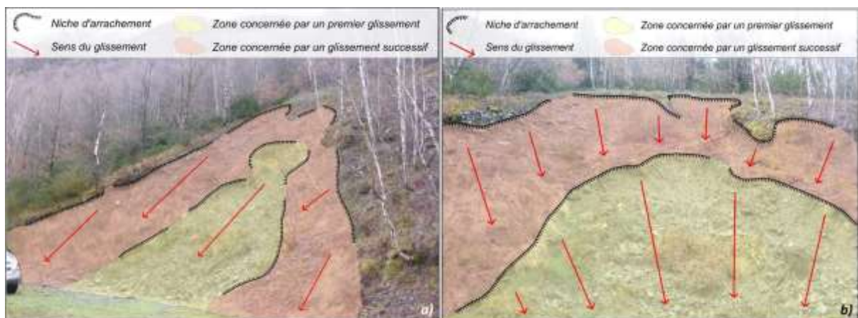
Figure 385 : Glissement avéré au lieu-dit Layroule. Les niches d'arrachement successives montrent l'évolution progradante du phénomène (Source AGERIN SAS )
