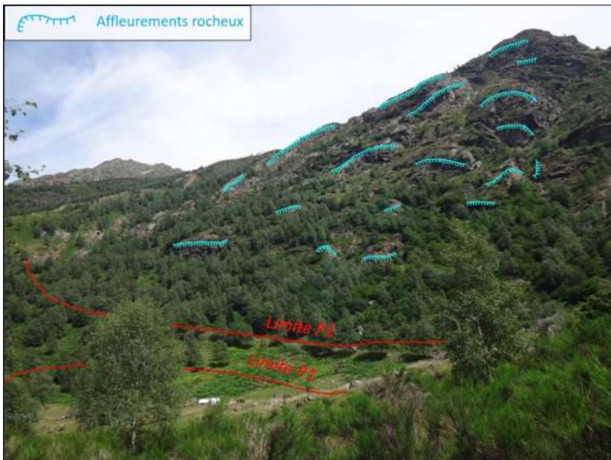
Figure 28 : Affleurements rocheux dominant le secteur du Pla de l'Isard et délimitation des zones d'aléa chute de blocs (Source AGERINsas)
