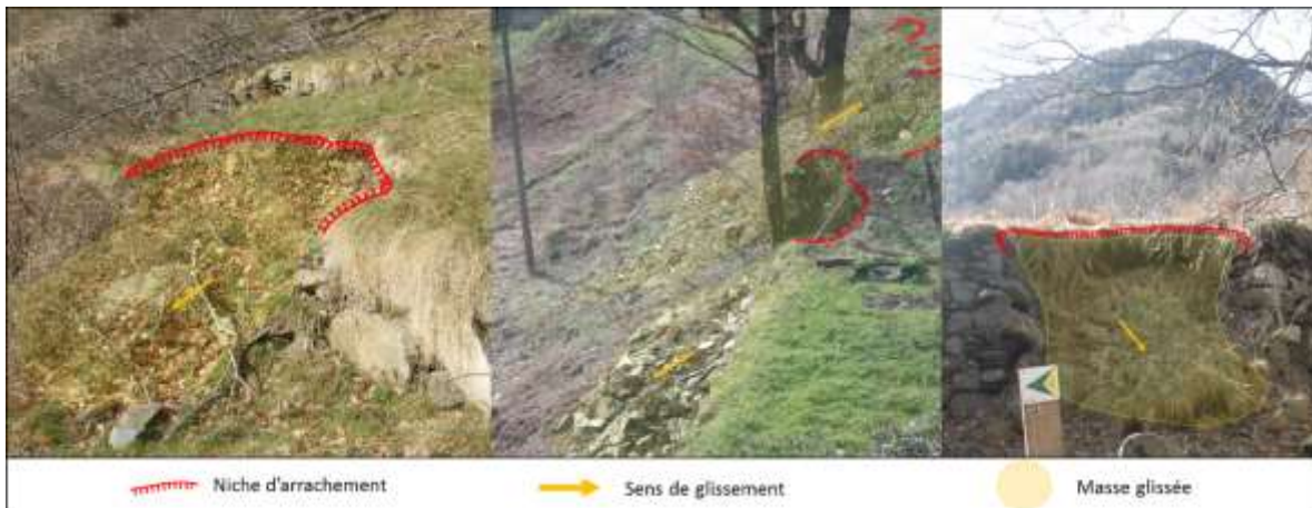
Figure 47 : Glissement de talus et murets sur le secteur Ensem – Hourré (Source AGERIN SAS )
