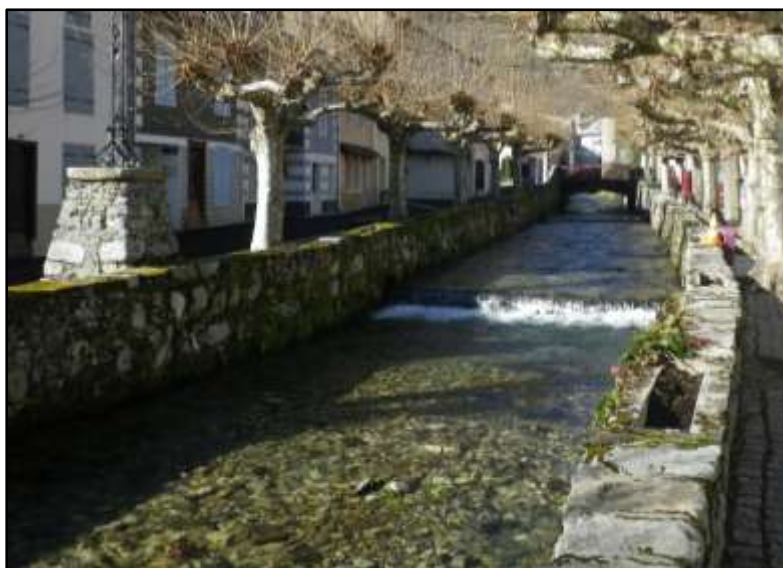
Figure 7 : Chenalisation du Saleix en aval de l'Eglise d'Auzat (source : AGERIN SAS )
