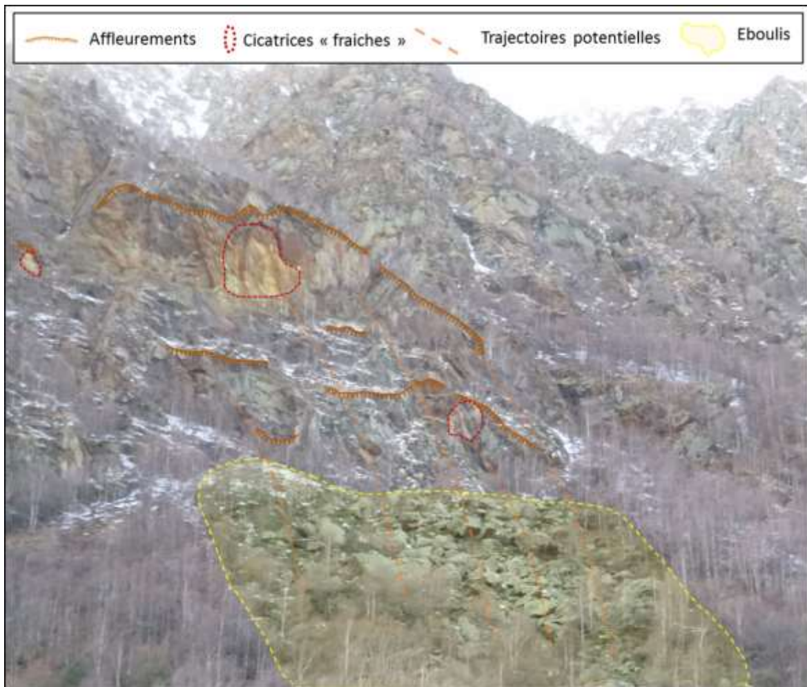
Figure 29 : Eboulement de masse sur le secteur Coustalas-les Echelles (Source AGERINsas)
