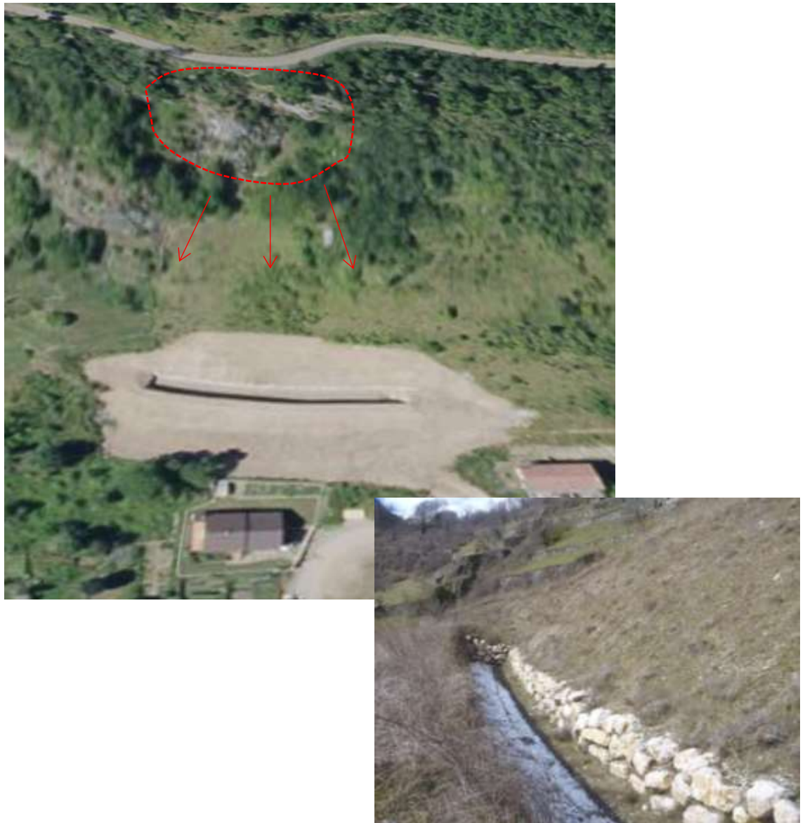
Figure 30 : Zone de départ et piège à blocs au lieu-dit Vexanne de Darré (Image IGN)
