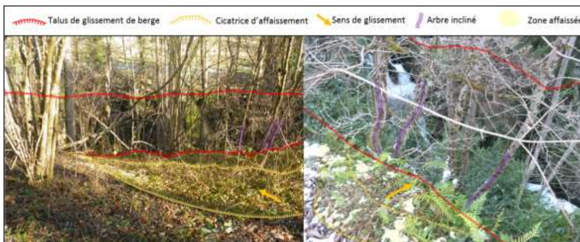
Figure 4136 : Affaissements sur les berges du ruisseau de Saleix (Source AGERIN SAS )
