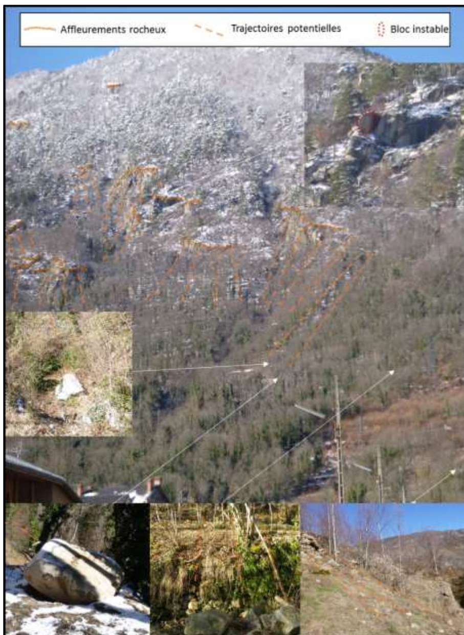
Figure 21 : Chutes de blocs sur le secteur Bégis-L'espladou (Source AGERINsas)
