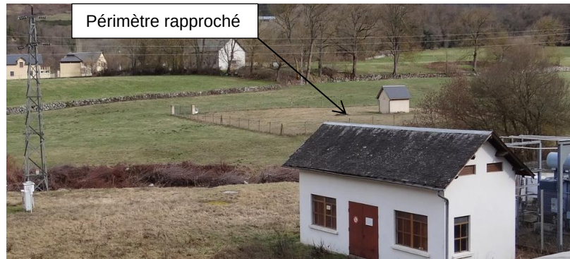
Le captage du Puits des Espeyoudes
