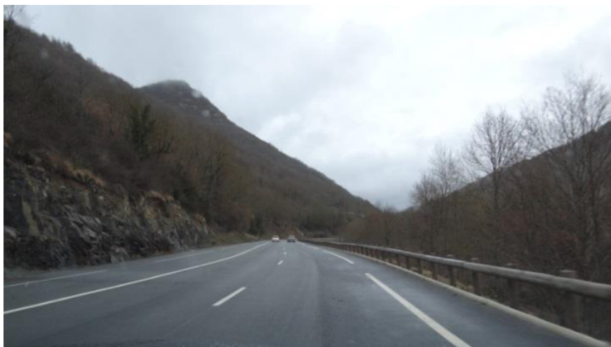
La RD929 au Nord d'Arreau : l'un des tronçons à 3 voies
