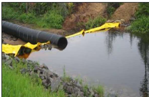
Traversée d'un cours d'eau en ensouillage
