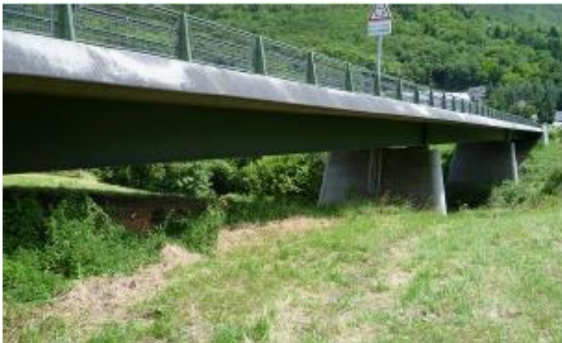
Photo 8 – Les liaisons souterraines à 225 000 volts passeront en encorbellement sur le pont de la RSD929 au Sud d'Arreau (mai 2017)
