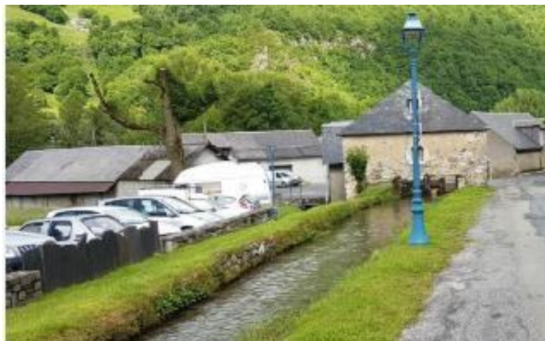
Le canal d'Ilhet sera mis hors d'eau et traversé en ensouillage
