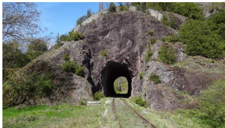
Le tunnel à l'amont de Camous
