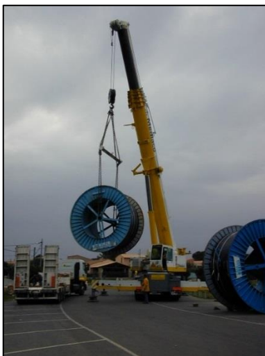
Touret de câble 63 kV (déchargement et déroulage)
