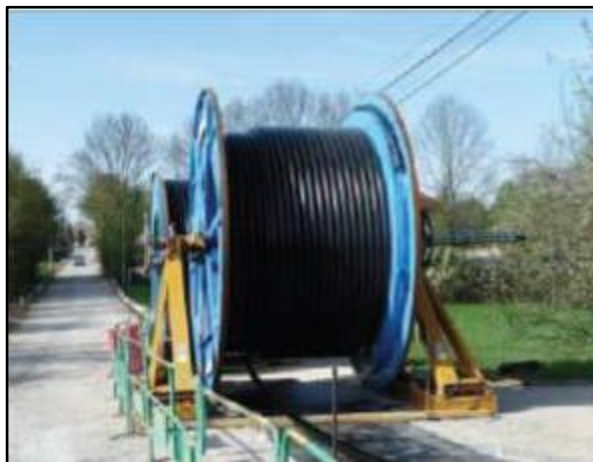
Touret de câble 63 kV (déchargement et déroulage)
