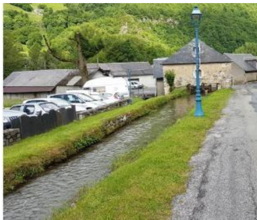
Le canal d'Ilhet au niveau de son franchissement par les liaisons souterraines
