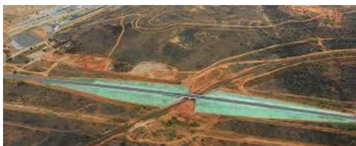
Photo 18 : Exemple de revégétalisation de talus par hydromulching dans le cadre de la construction d'une route (image spraygrassaustralia.com)
