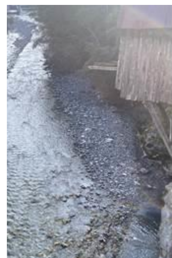
Photo 16 : Vue de l'atterrissement sur lequel sera réalisée la piste d'accès
