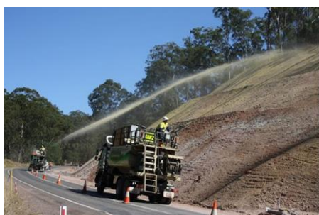
Photo 17 : Mise en place des semences, des engrais et des agents stabilisants (fixateur et hydromulch) (image gahydromulching.com)
