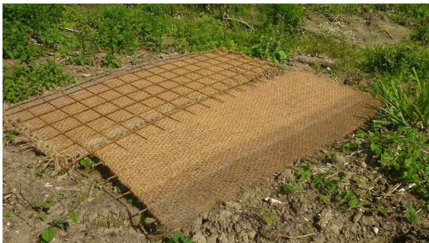
Photo 16 : exemple de barrière anti MES (Image HYDROSPHERE)
