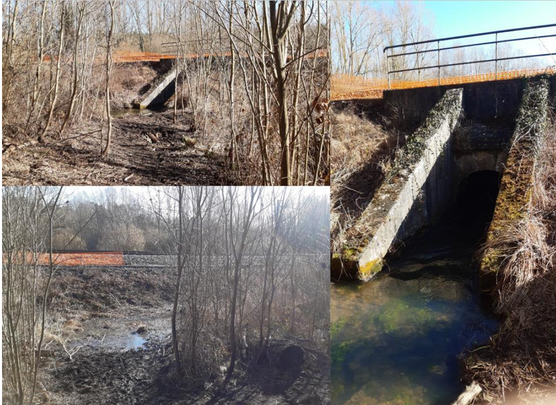
Figure 3 : Localisation de l'ouvrage actuel – Amont
