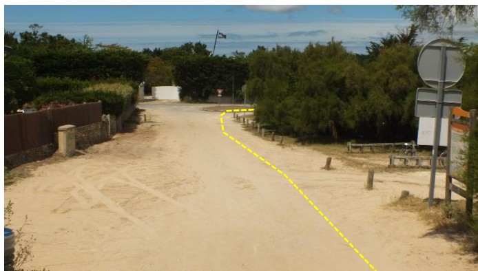
Figure 8 : Déplacement de la ligne de plots anti-pénétration (ligne jaune) permettant de rétrécir la voie en conservant le revêtement
