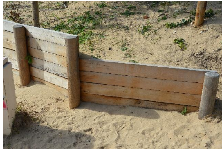
Soutènement bois pour retenir le talus le long du sentier piétons
