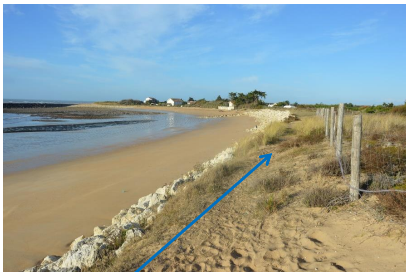
A marée haute, passage piétons impossible par la plage. Les piétons passent en haut de l'enrochement et dégradent la dune.
