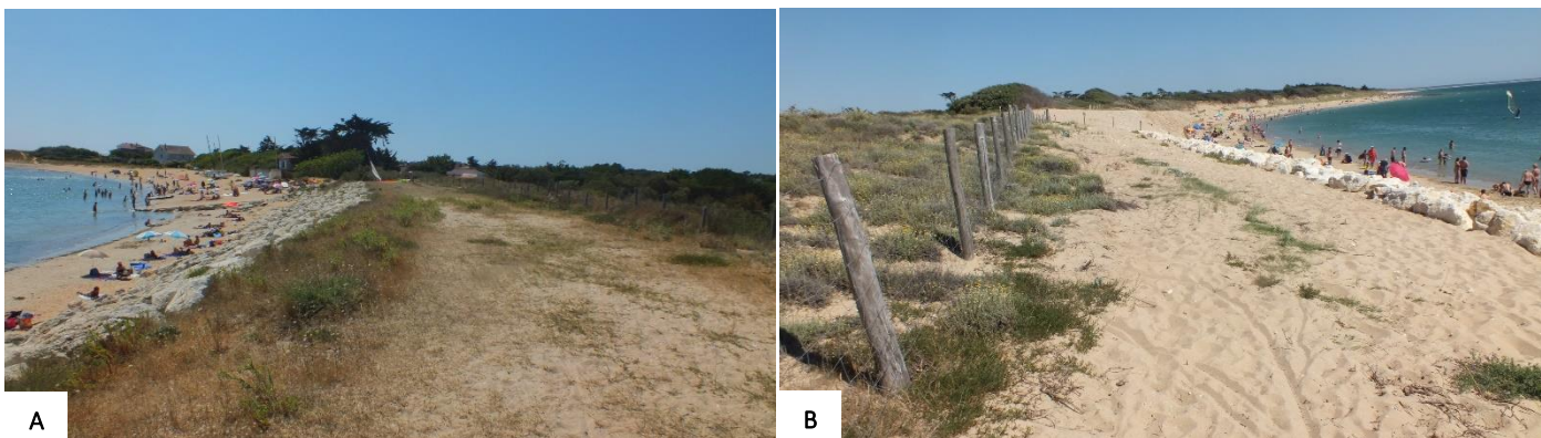
Figure 3 - A et B : Cheminement entre les enrochements et les dunes grises dégradant la couverture végétale et mettant le sable à nu
