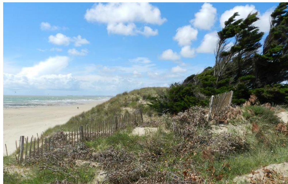
Pose de branchage pour capter le sable
