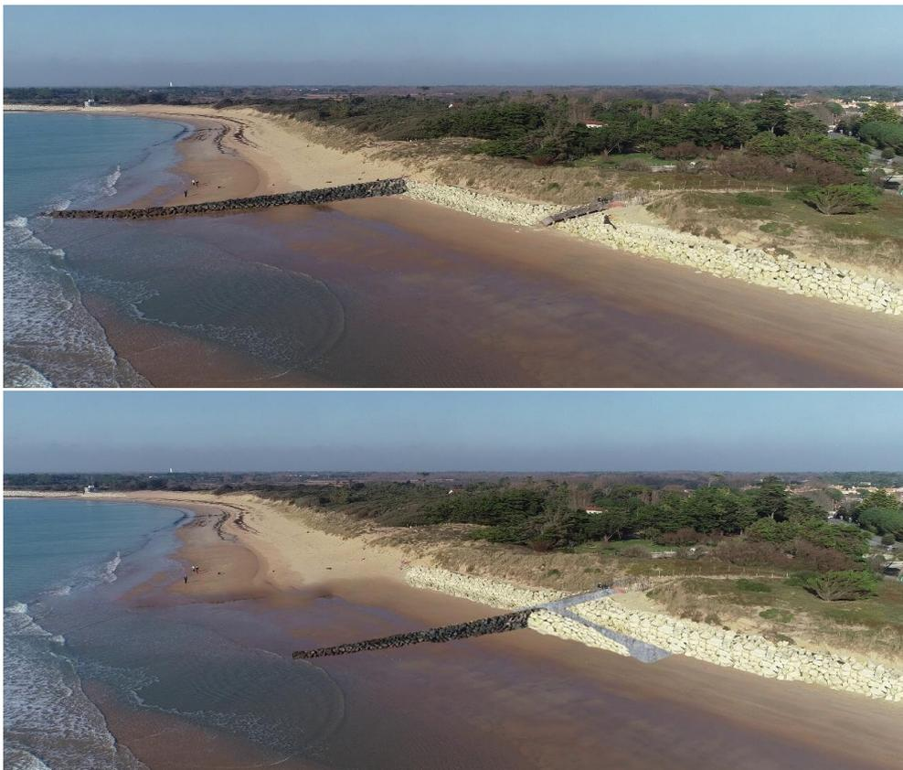
Figure 5: Vue générale de l'ouvrage en configuration actuelle (en haut) et projetée (en bas)
