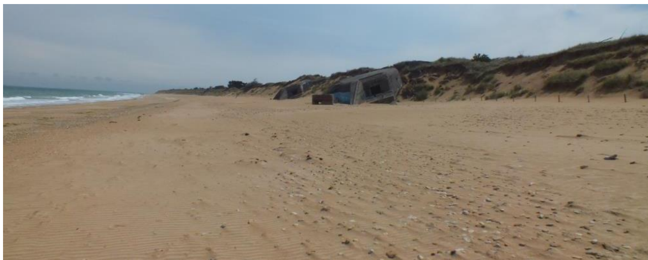
Figure 3 : Blockhaus de Couny ayant glissé le long de la falaise dunaire en 2015
