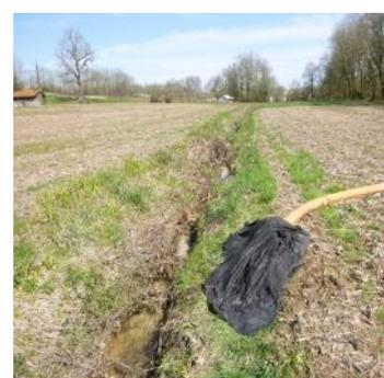
**A gauche : rejet dans une « chaussette » en géotextile, orienté de façon parallèle au ruisseau et profitant d'une surface végétalisée, afin de favoriser la filtration naturelle. Au centre : rejet aménagé et orienté vers un fossé de drainage afin d'éviter le ruissellement sur la parcelle agricole.**
