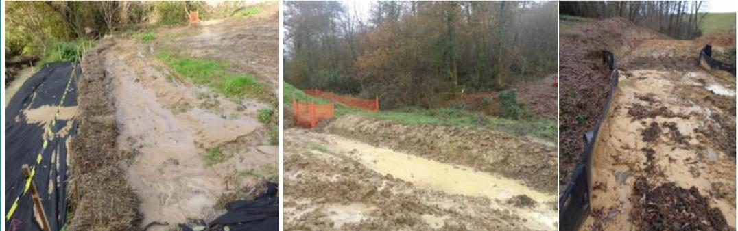
**Exemples de pièges à sédiments (de gauche à droite : boudins de rétention, merlon et barrière géotextile), à privilégier le long des emprises de chantier, des cours d'eau et des zones humides (source : ARTELIA)**
