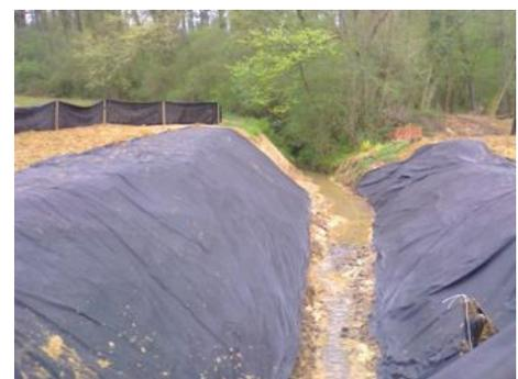
**A gauche, exemple de protection multi-dispositif (fossé piège à sédiment + système tampon + barrière provisoire) entre une zone de déblais/remblais et une zone humide. A droite,**
